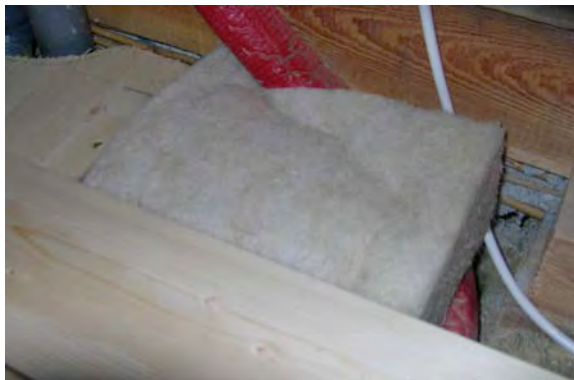
Abbildung 45 Versuchsteil als Bodendämmstoff
