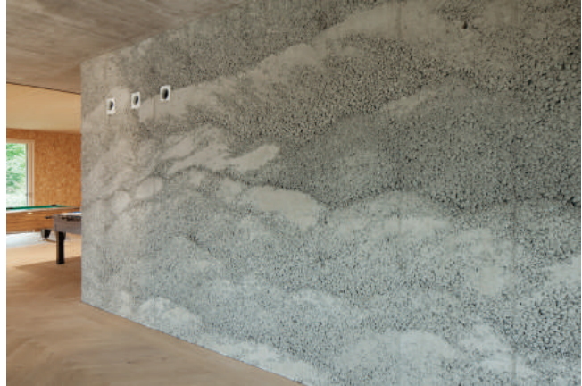
Abbildung 3: Stampfbetonkern (© Andrew Phelps)
