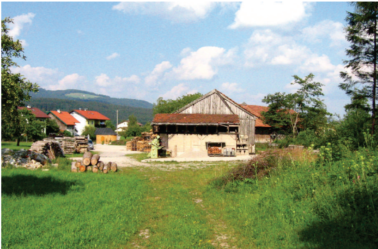
Abbildung 12: Bauplatz (© sps-architekten zt gmbh)
