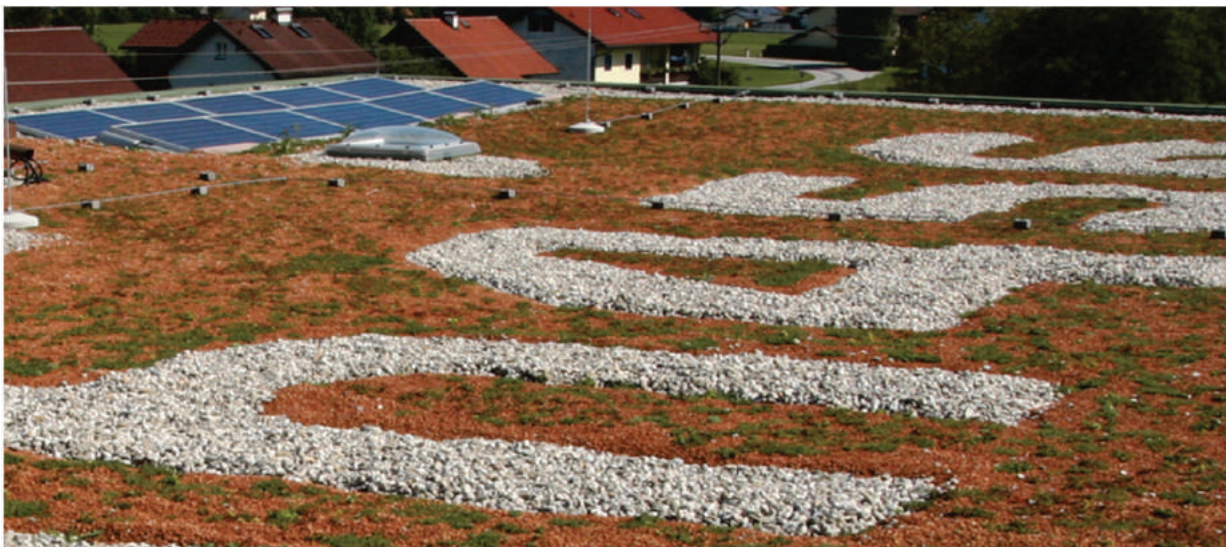
Abbildung 8: Flachdach und PV-Anlage (© sps+architekten zt gmbh)
