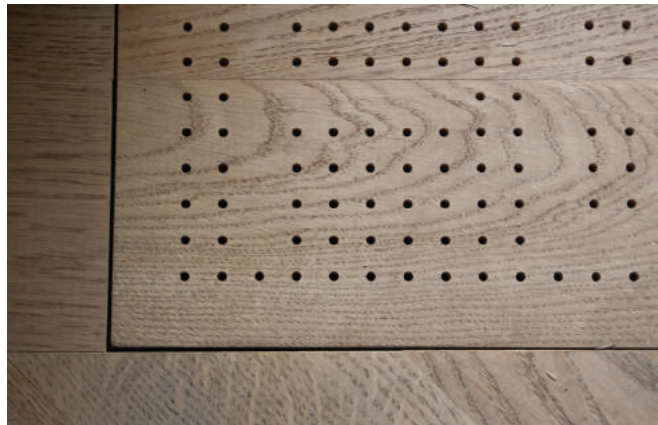
Abbildung 6: Lüftungsauslässe in Zirbenholz (© sps+architekten zt gmbh)
