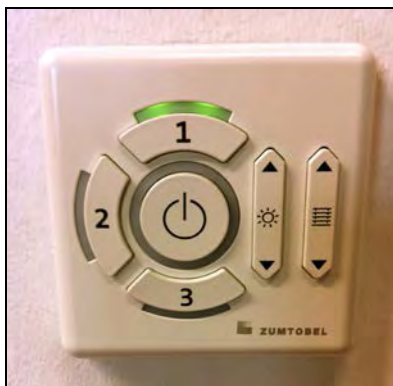
Abbildung 7: ENERGYbase, Steuerungspaneel für Beleuchtung und Jalousien
