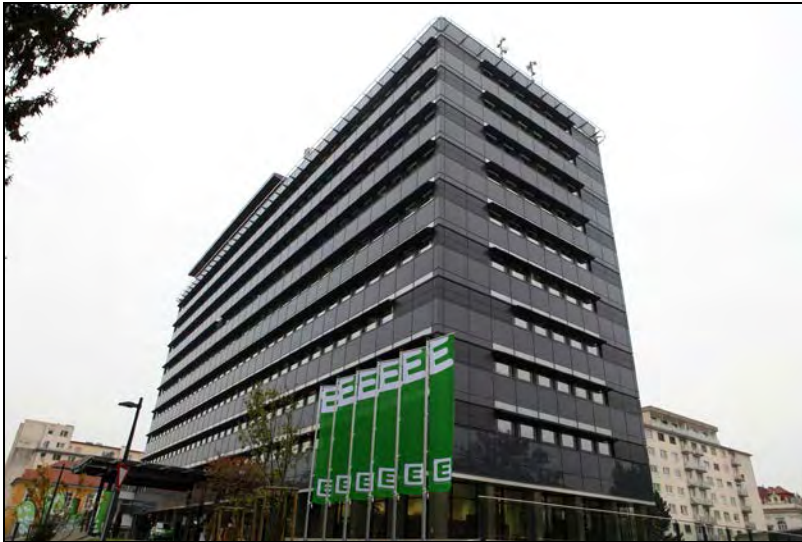
Abbildung 5: Headquarter der Energie Steiermark in Graz
