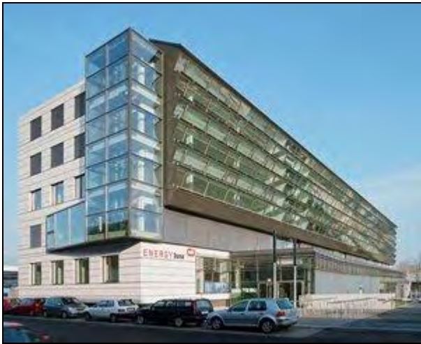
Abbildung 4: Gebäude der ENERGYbase in Wien
