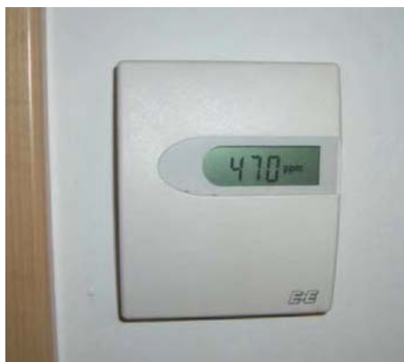
Abbildung 13: CO 2 -Feuchte-Temperatur-Sensor
