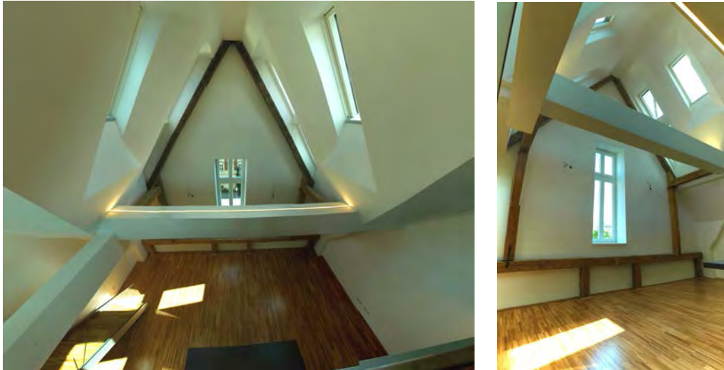
Abbildung 2-26: saniertes denkmalgeschütztes Gespärre in Dachgeschosswohnung (Quelle: Architekt Kronreif_Trimmel&Partner)
