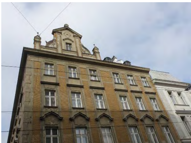
Abbildung 2-17: Straßenfassade mit Riemchen, Kastenfenster, Gaube vorher- nachher (Quelle: Architekt Kronreif_Trimmel&Partner)
