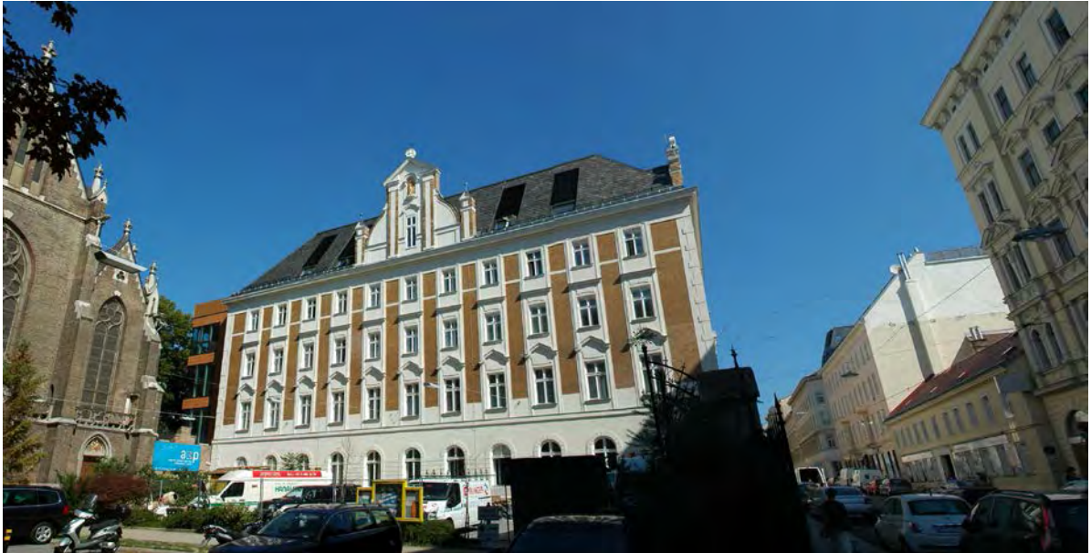
Abbildung 3-1: Kaiserstraße 7 nach der Sanierung (Quelle: Architekt Kronreif_Trimmel&Partner)
