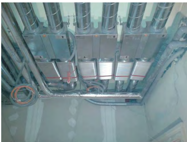
Abbildung 2-10: Lüftungsführung 2.OG, Verteilerboxen, Schalldämpfer (Fotos: Architekten Kronreif_Trimmel&Partner)
