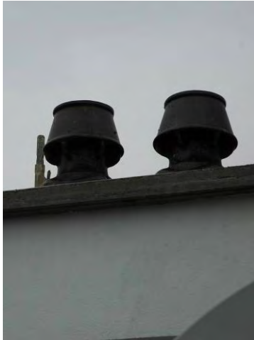
Abbildung 2-20: Keramik-Aufsätze - Kamine saniert (Quelle: Architekt Kronreif_Trimmel&Partner)
