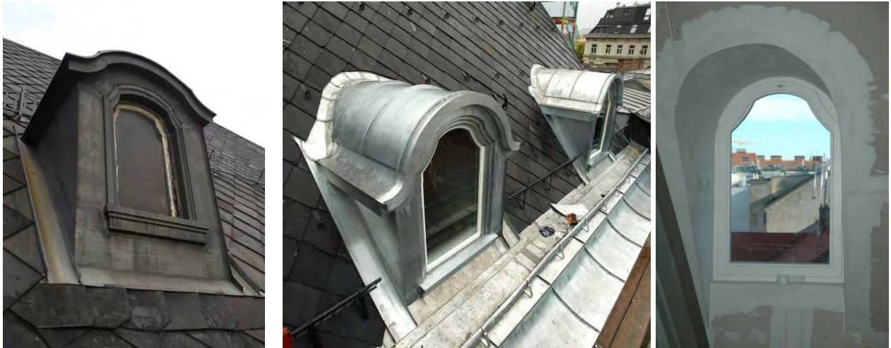
Abbildung 2-12: Fotos Gaupen straßenseitig vor und nach Sanierung (Quelle: Architekten Kronreif_Trimmel&Partner)
