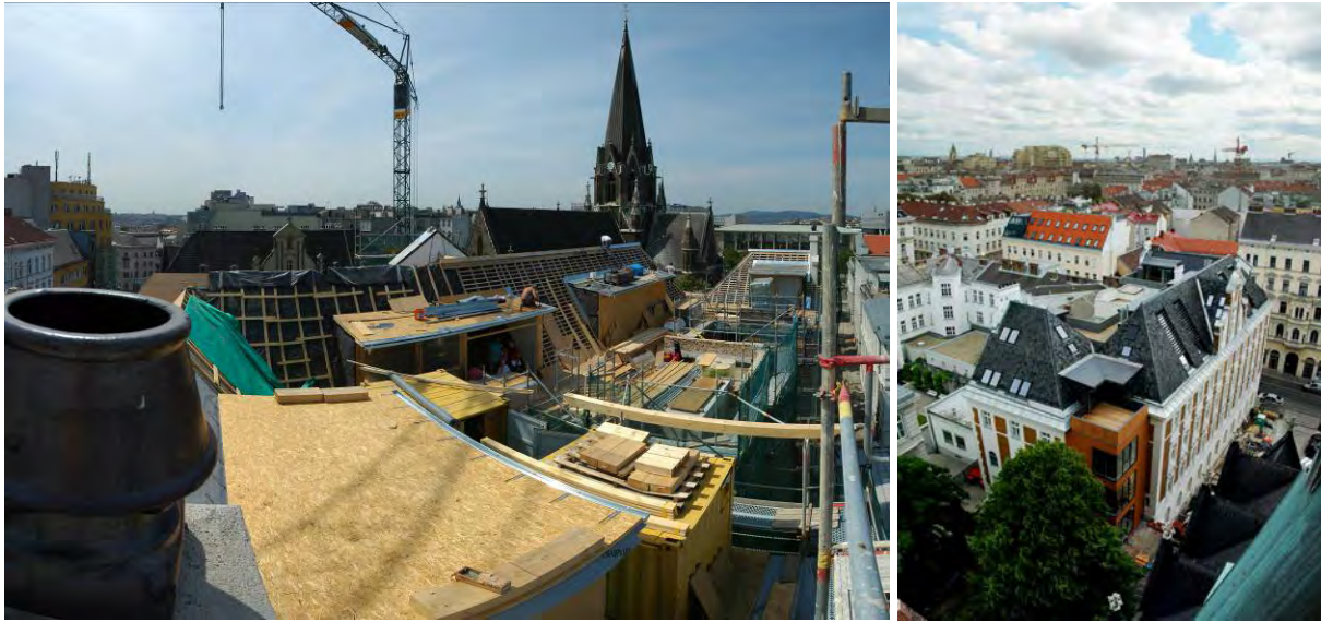
Abbildung 1-4: Übersichtsfoto Baustelle, Übersichtsfoto BDA Fassaden und Dach fertiggestellt (Quelle: Architekten Kronreif_Trimmel&Partner)
