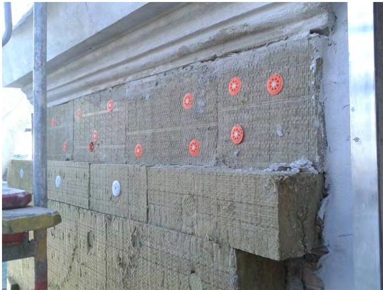
Abbildung 2-7: Hoffassade- Dämmung (Quelle: Architekten Kronreif_Trimmel&Partner)
