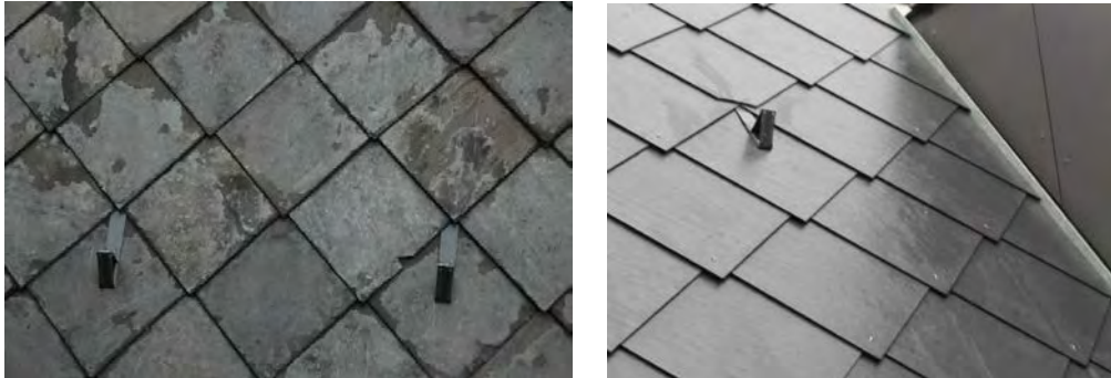
Abbildung 2-22: Schieferdeckung- Eternitschablone Vergleich (Quelle: Architekt Kronreif_Trimmel&Partner)
