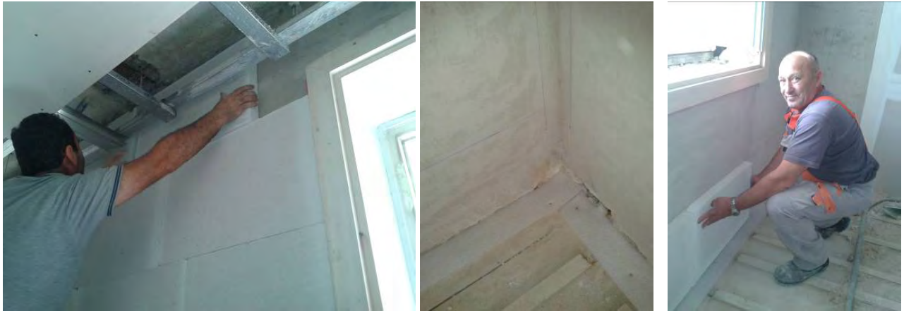
Abbildung 2-3: Fotos von Innendämmungsherstellung (Quelle: Architekten Kronreif_Trimmel&Partner) Arbeitspaket 2 - Thermische Sanierung der denkmalgeschützten Kastenfenster
