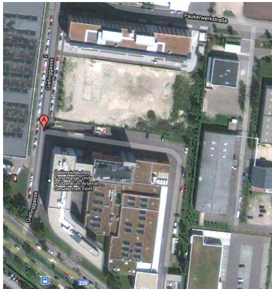
Abbildung 20: Bauplatz zwischen TECHbase (unten) und ENERGYbase (oben)
