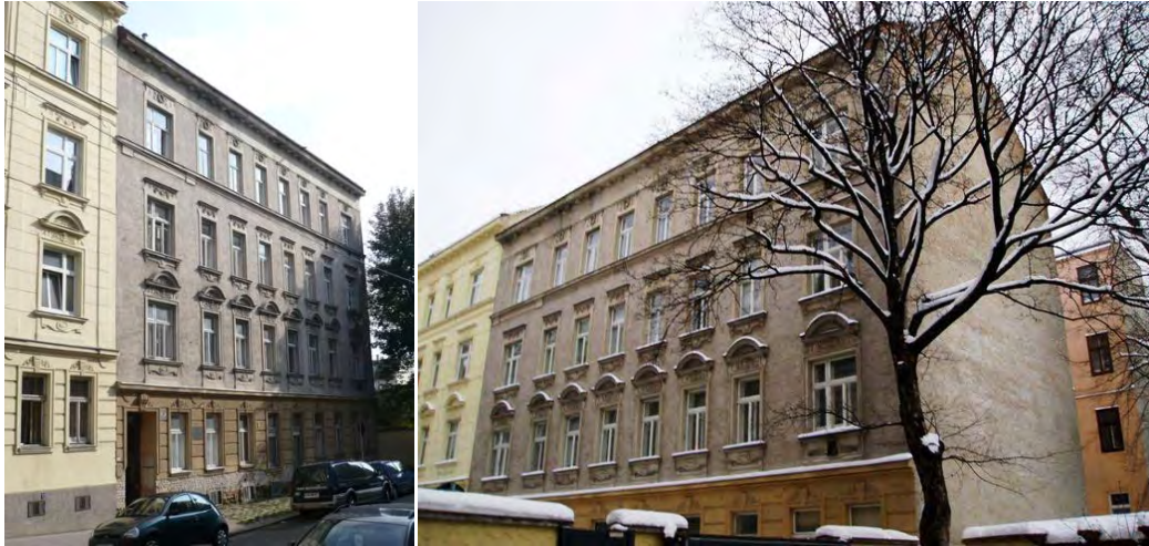
Abbildung 1: Ansichten der gegliederten Fassade und der südseitigen Feuermauer 1
