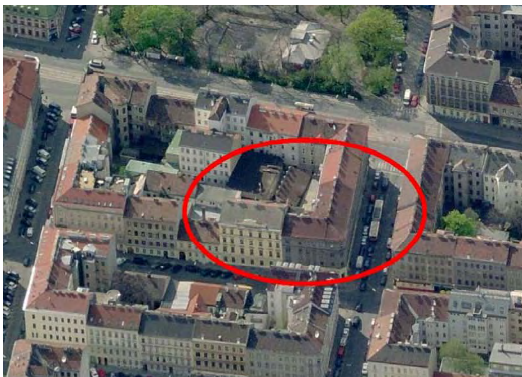
Abbildung 3: Luftbild Ensemble "David's Corner"
