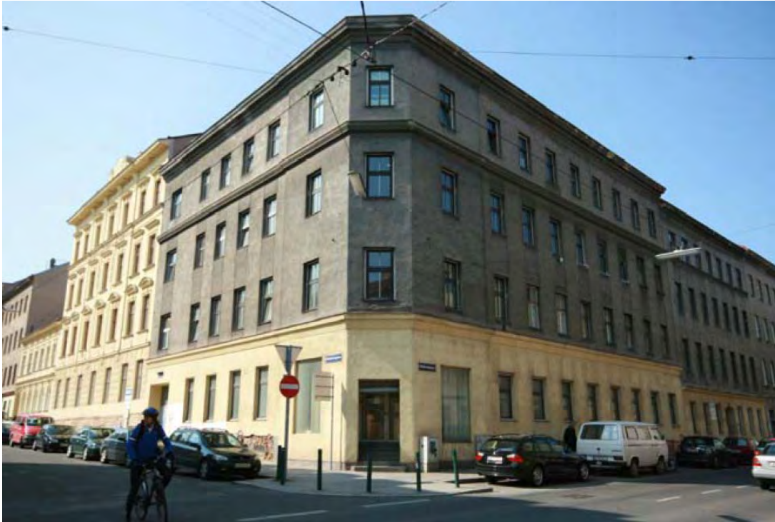
Abbildung 4: Straßenansicht Muhrengasse 18, Muhrengasse 16, Davidgasse 23 (v.l.n.r.)
