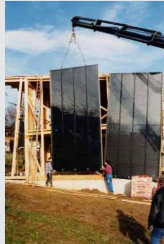
Bild: Montage der Kollektoren der Testfassade mit Hilfe eines Kranes [AEE INTEC]
