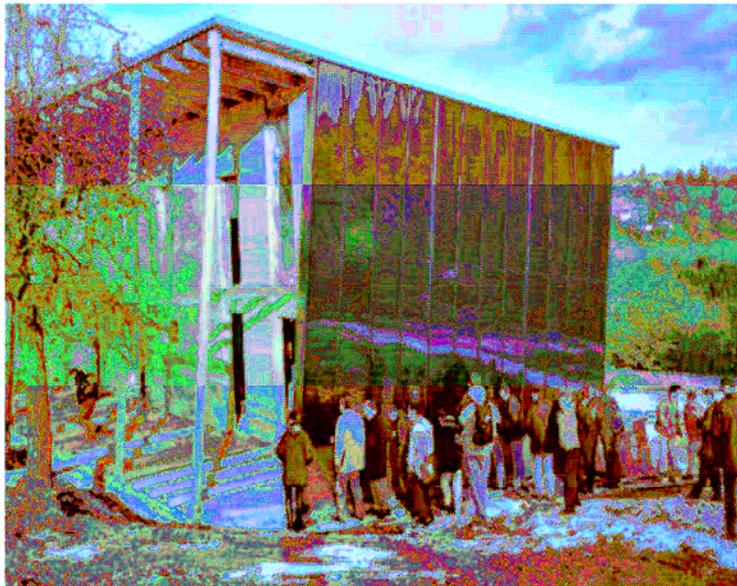
Abbildung 7.3: Testfassade mit 55 m<sup>2</sup> Kollektorfläche auf einem Zweifamilienwohnhaus in Graz
