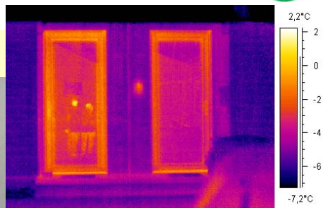
Thermografieaufnahme zur Messung von Wärmebrücken, hier:
