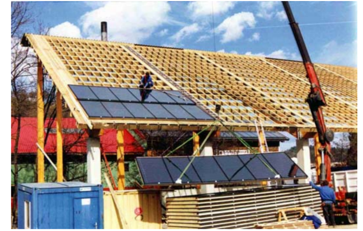
Bild 3: Montage von Großflächen-Kollektormodulen in Eibiswald (Foto: SOLID)
