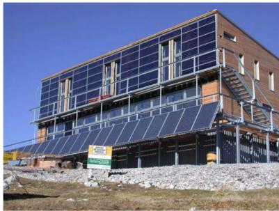
Bild 1: Fassaden Sonnenkollektoren
