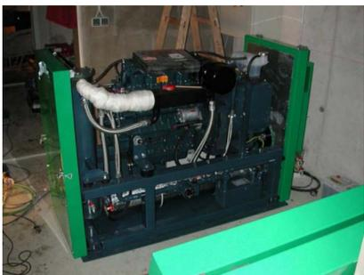
Bild 3: Rapsöl-betriebener Notstromgenerator mit Wärmeauskopplung
