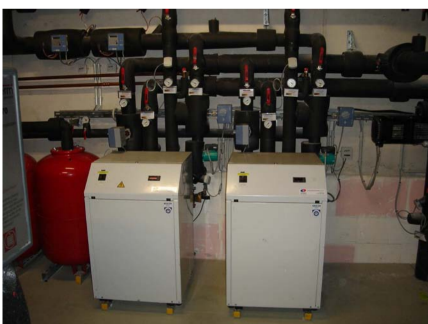
Links: Wärmepumpen und gedämmte Armaturen; Lüftungsanlage Unten: Eingangshalle, Unten rechts: Büroraum mit Sichtbetondecke, Passivhaus-Schiebetüre, Lehmputz
