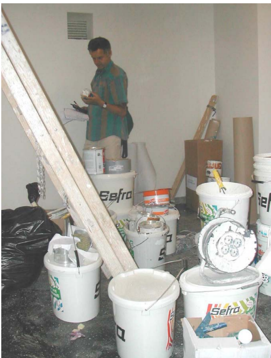
Baustellenkontrolle im Zuge des Chemikalienmanagements
