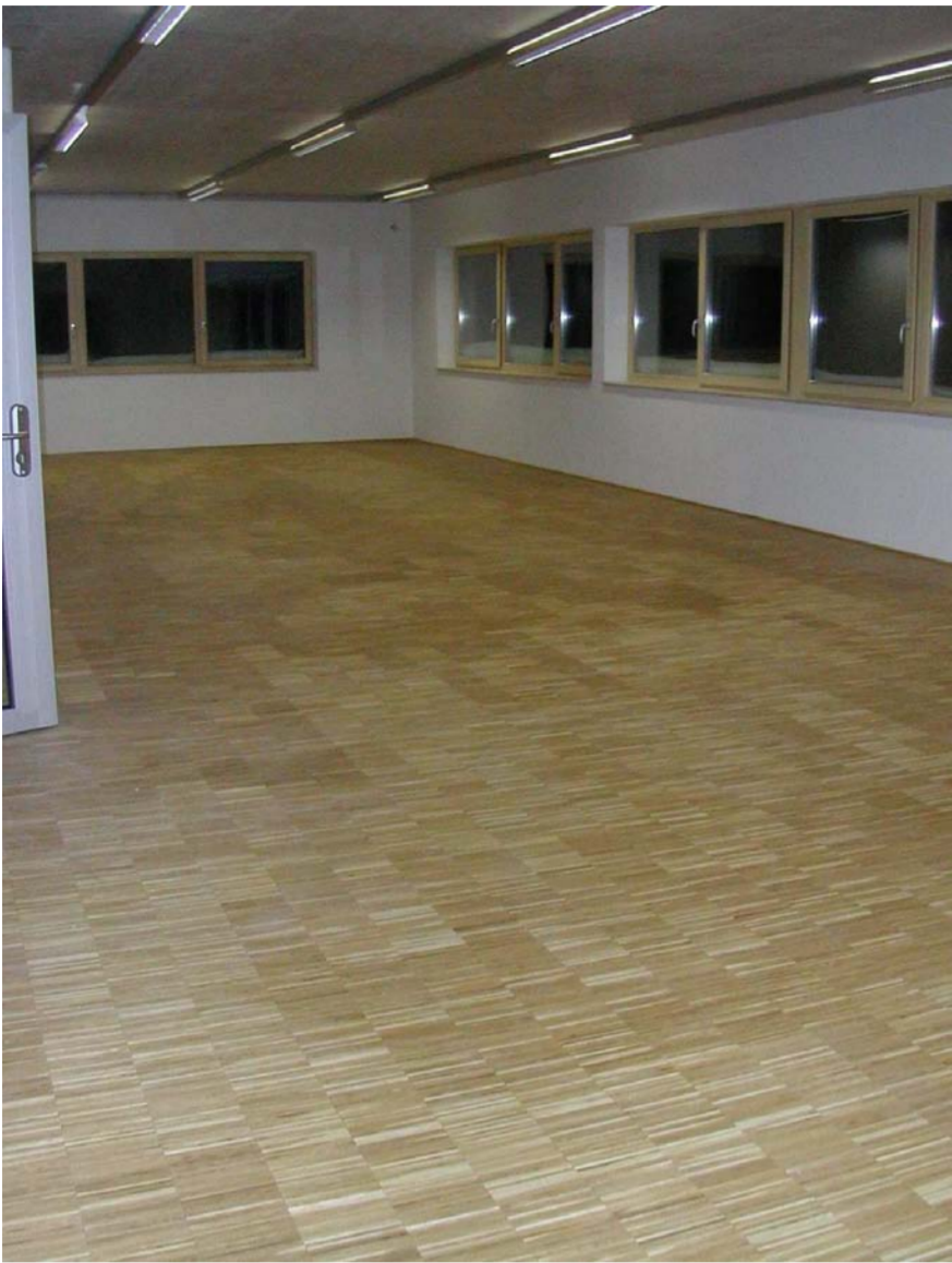
Großflächiger Einsatz nachwachsender Rohstoffe, hier Parkett, mit emissionsarmen Klebstoffen und Lacken verlegt
