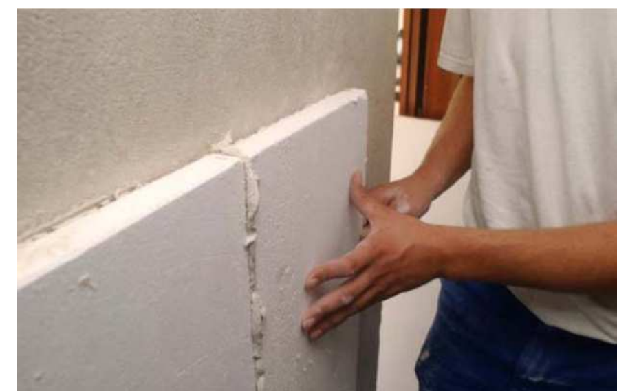
Innendämmung mit Calciumsilikatplatten
