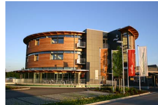
Christophorushaus; Bildquelle: Beschaffungsbetrieb der Missions-Verkehrs-Arbeitsgemeinschaft
