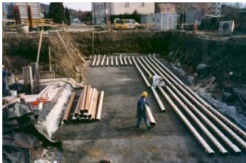
Abbildung 10: Verlegung des Erdreichwärmetauschers im W.E.I.Z.
