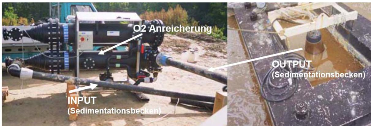
Abbildung 38: Gaseintragsystem – Durchfluss 200 m<sup>3</sup>/h
