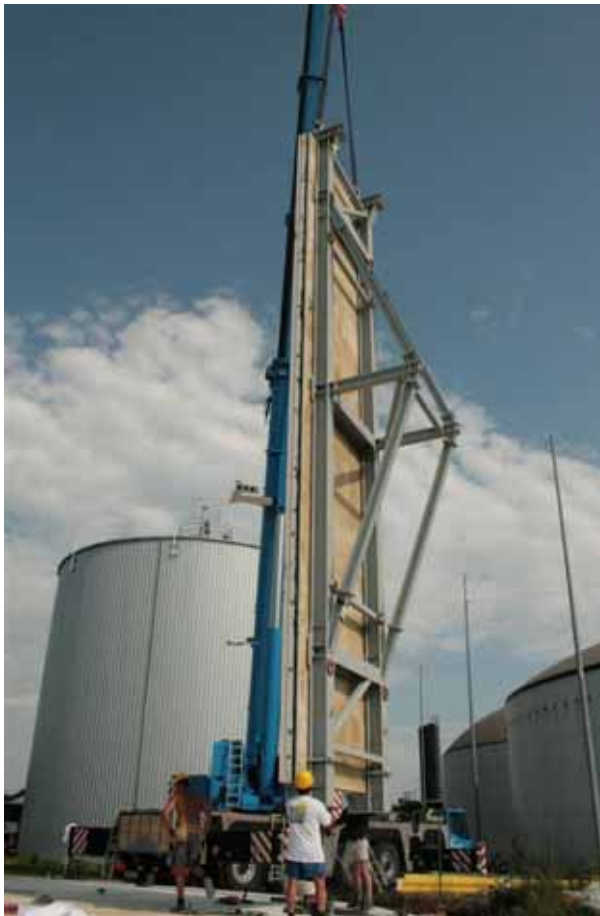
Manipulation der Fertigteile auf der Baustelle mit dem eigens konzipierten Montagerahmen
