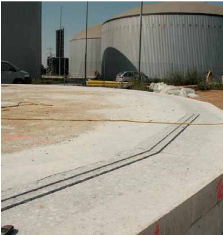
Links: Fertig geschliffenes Fundament mit bereits eingearbeiteten Nuten zur Aufnahme der Dichtung Rechts: Reprofilierter Nut mit Dichtungsband, die zweite Nut dient der nachträglichen Verpressung
