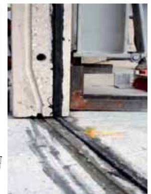
Fugendetail Bodenplatte - Wandelement
