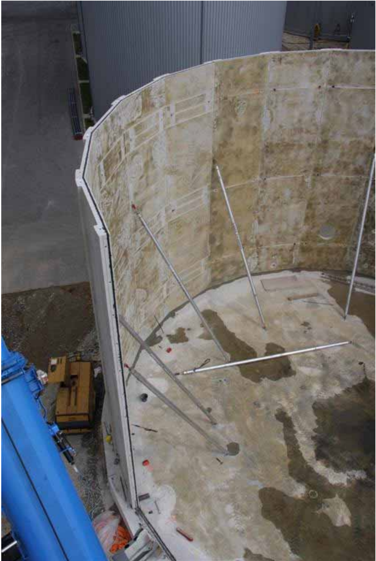
Vogelperspektive während der Montage. Gut sichtbar der rundum sichtbare Dichtungsrahmen
