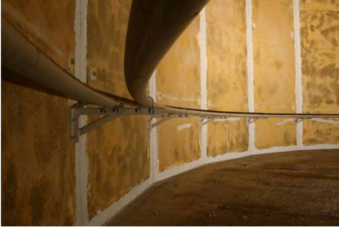
Fertig sanierter Behälter mit Heizleitungen
