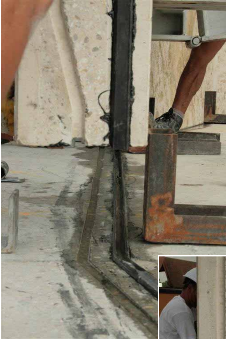
Absetzen eines Wandelements
