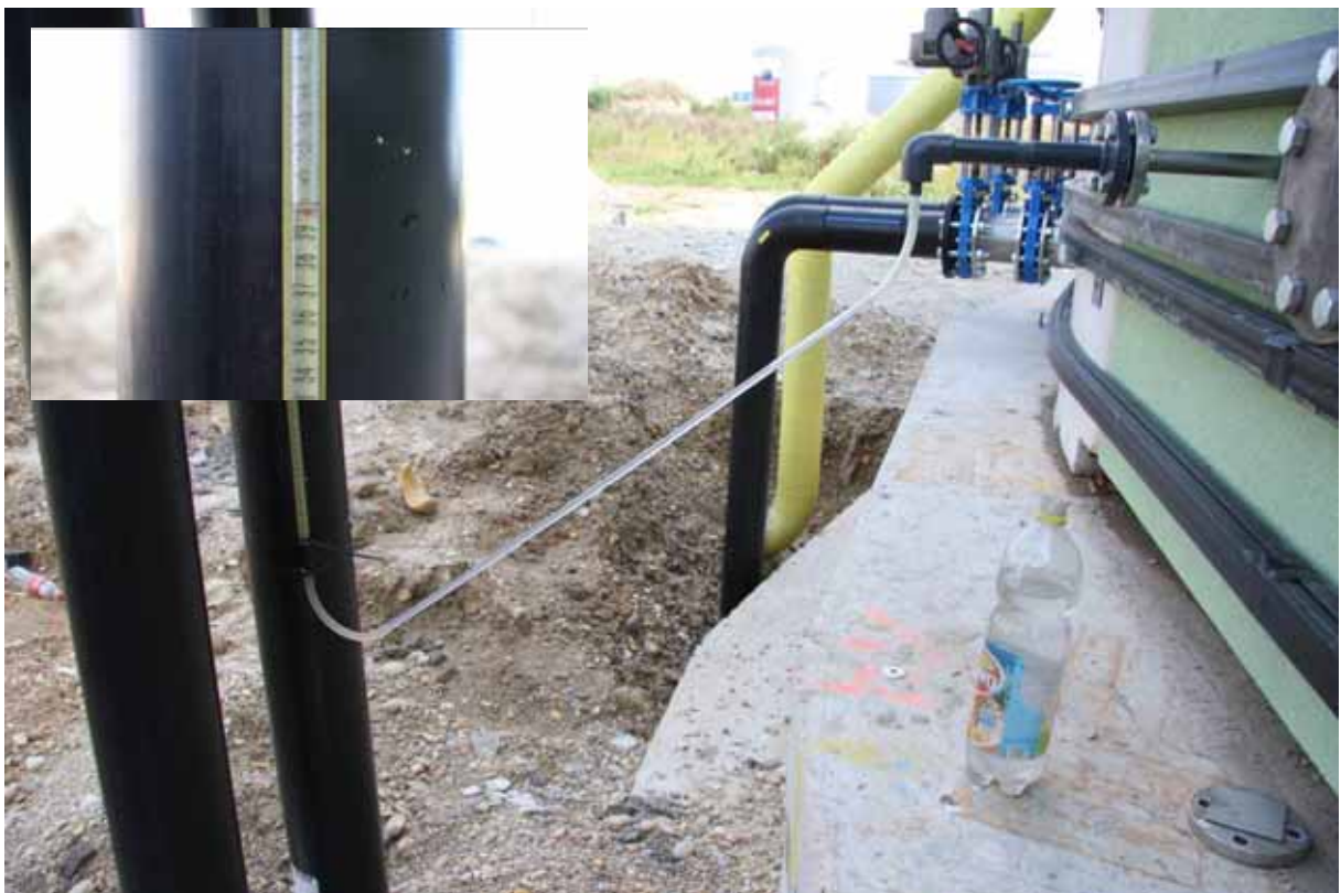
Durchführung der Dichtigkeitsprüfungen mit einem Standrohr
