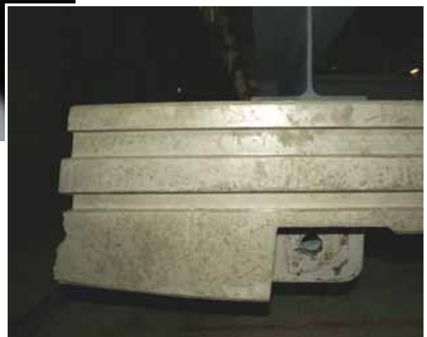
Links: Element mit aufgebrachtener Dichtung Rechts: Element vor aufbringen der Dichtung (2 Nuten erkennbar – in eine wird die Dichtung eingeklebt, die andere dient zu nachträglicher Verpressung)
