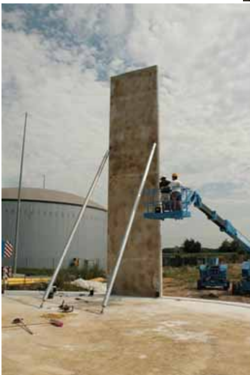
Absetzen eines Wandelements
