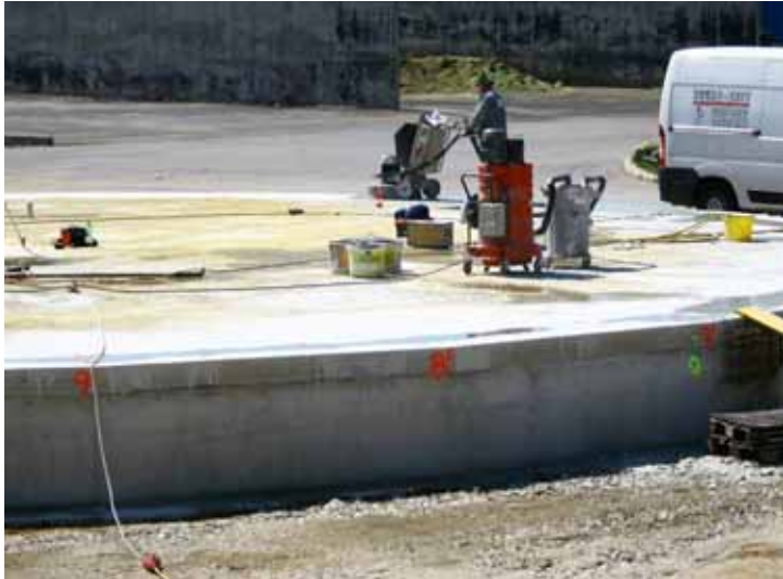
Ebenschleifen der Bodenplatte mit Diamantschleifmaschinen. Gefordertes Ebenheitsmaß +/- 1mm!
