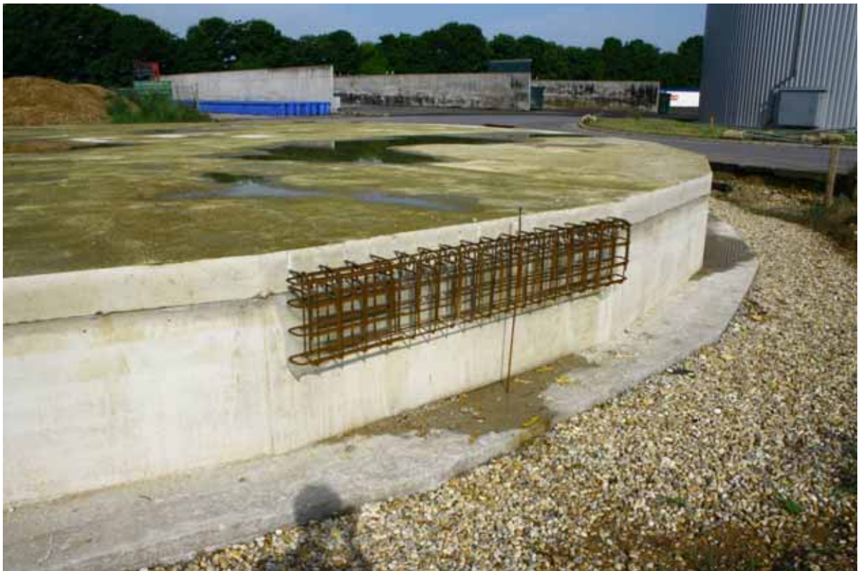
Fertiggestelltes Fundament inklusive Sanierung (obere 20cm starke Platte)
