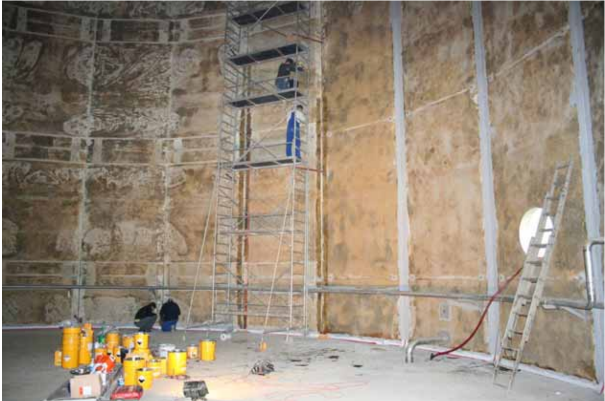
Sanierungsarbeiten im Inneren des Behälters It. Sanierungskonzept. Abdichtungen bis in eine Höhe von 12m sowie über Kopf an der Decke.
