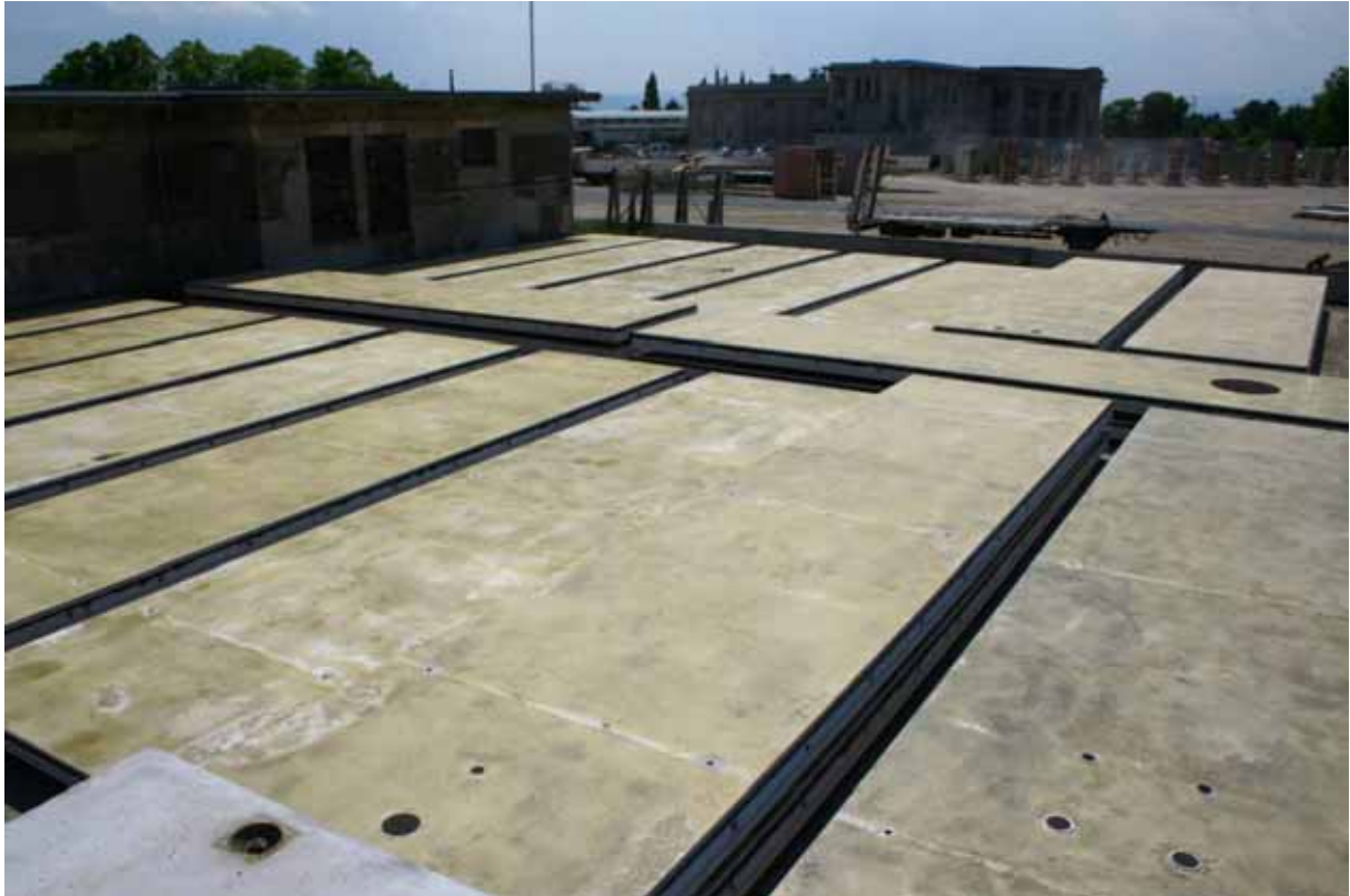
Lagerung der Fertigteile auf dem Lagerplatz
