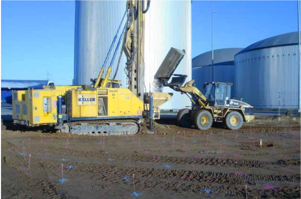
Bodenverbesserungsmaßnahme Rüttelstopfverdichtung
