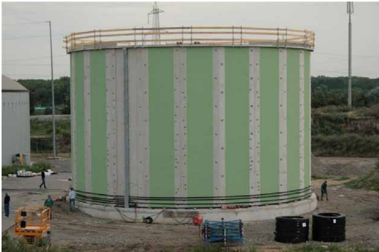
Fertiggestellte Wärmedämmung und erste eingelegte Vorspannkabel
