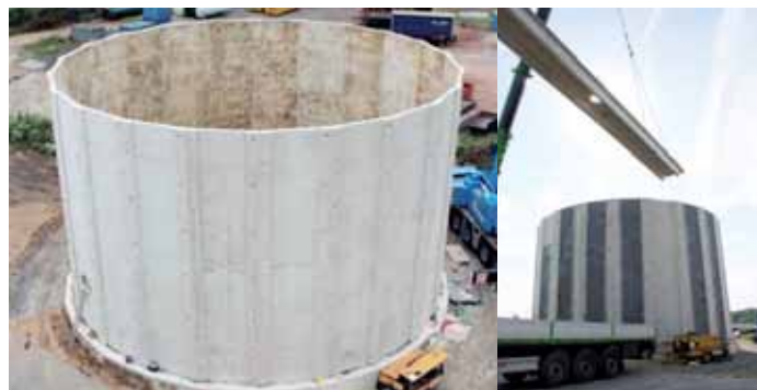
Montage Wand- und Dachelemente
