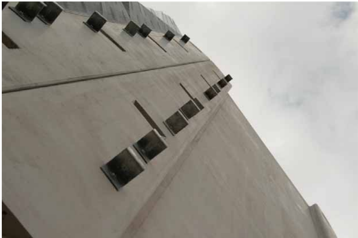
Montierte Z-Montagewinkel für die Aufnahme der Spannkabel
