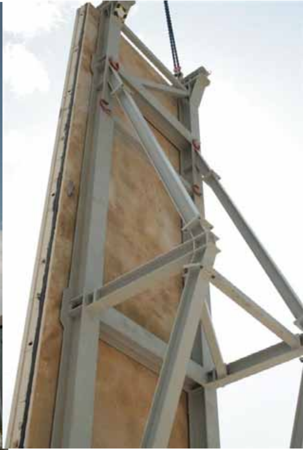
Manipulation der Fertigteile auf der Baustelle mit dem eigens konzipierten Montagerahmen
