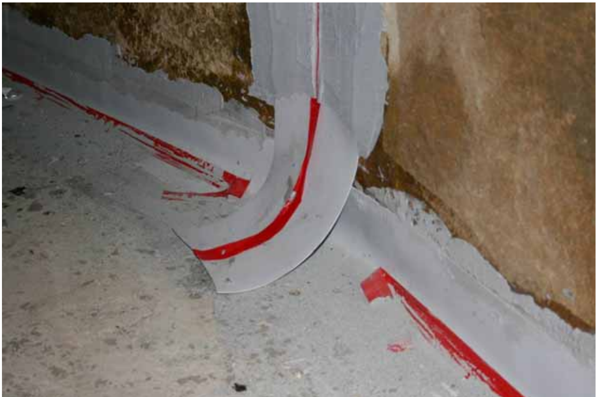
Dichtungsbandstoß (In Epoxydharzbett versetzte Hypalonkunststoffdichtungsbänder)
