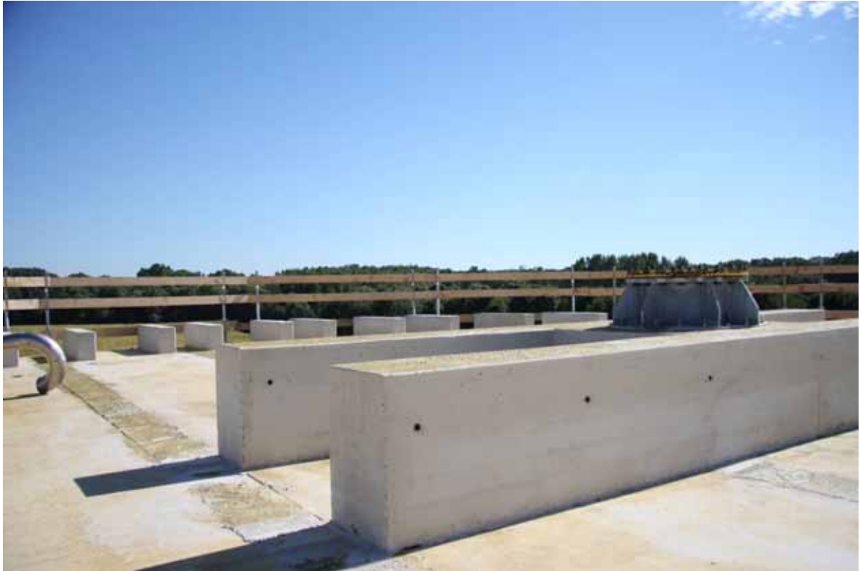
Fertiggestellte Decke samt Aussteifungsträger und Rührwerksflansch. Im Hintergrund sind die Überzüge der Deckenträger zu erkennen.
