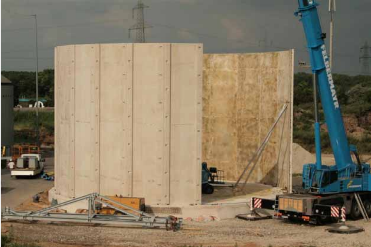
Während der Montage (Oben: Schrägstützen dienen zur Versteifung)
