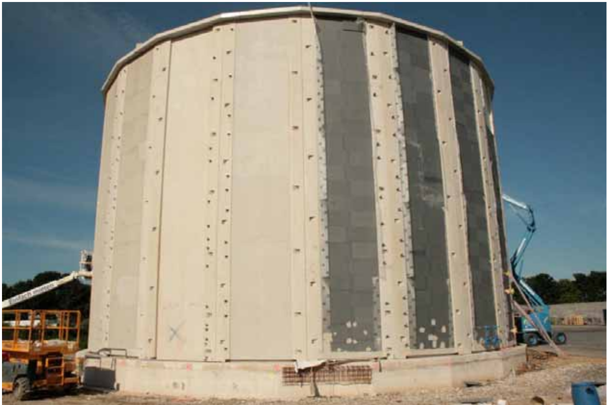
Aufbringen der Wärmedämmung und Versetzen der Deckenelemente
