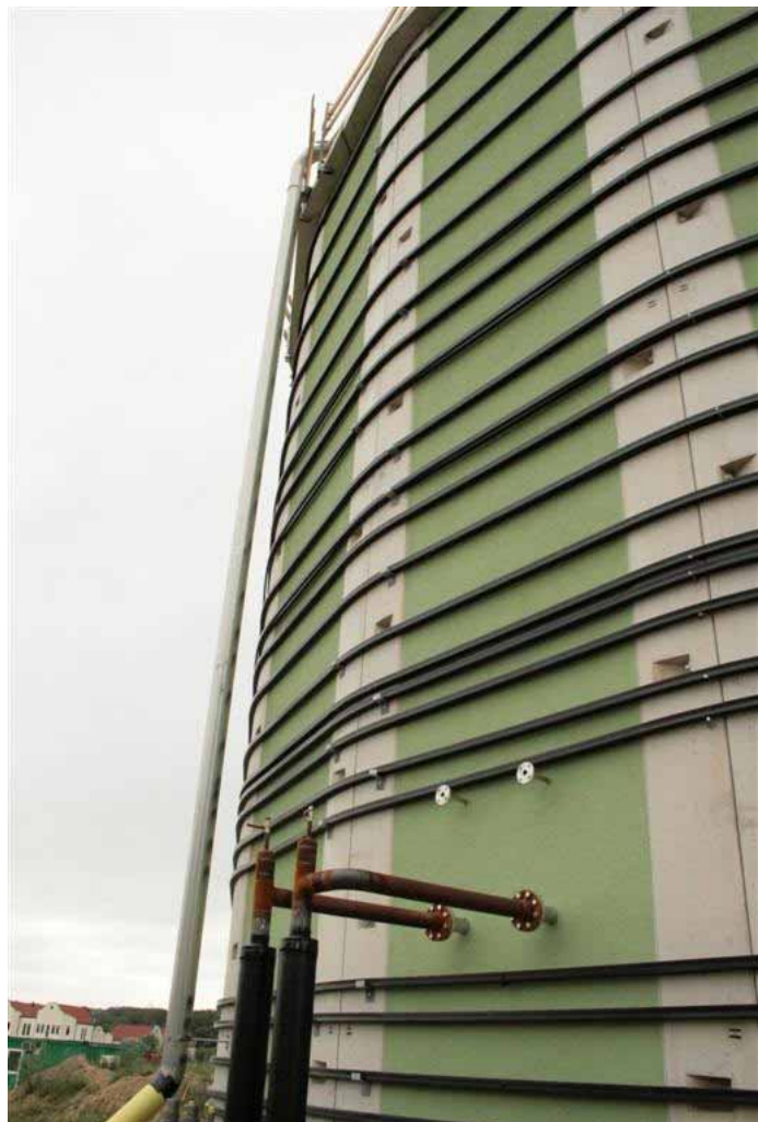
Verspannen der Spannkabel mit ~80 t/Kabel
