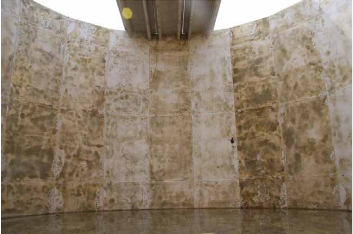
Während der Deckenmontage
