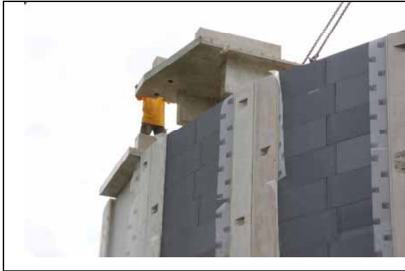
Bild 4: Nach der Außenwand-Dämmung folgt das Einhängen der Deckenelemente
