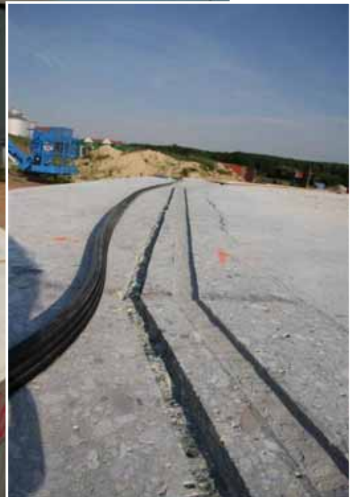
Links: Fertig geschliffenes Fundament mit bereits eingearbeiteten Nuten zur Aufnahme der Dichtung Rechts: Reprofilierter Nut mit Dichtungsband, die zweite Nut dient der nachträglichen Verpressung
