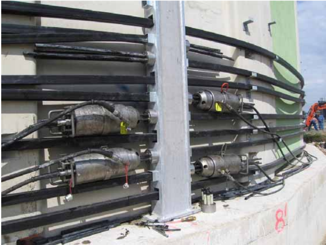
Verspannen der Spannkabel mit ~80 t/Kabel
