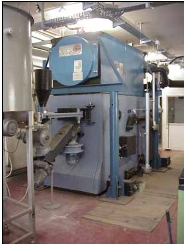
Abbildung 3 : Feuerungsanlage
