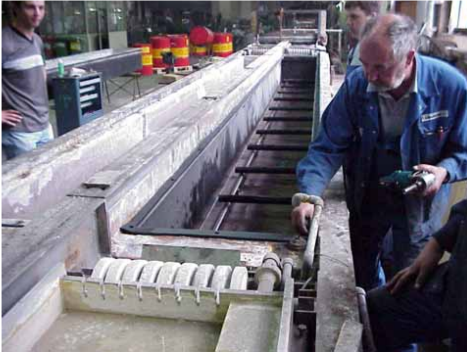
Abbildung 27: Ölwanne (elektr. beheizt) für indirekte Beheizung des Phosphatbades 2
