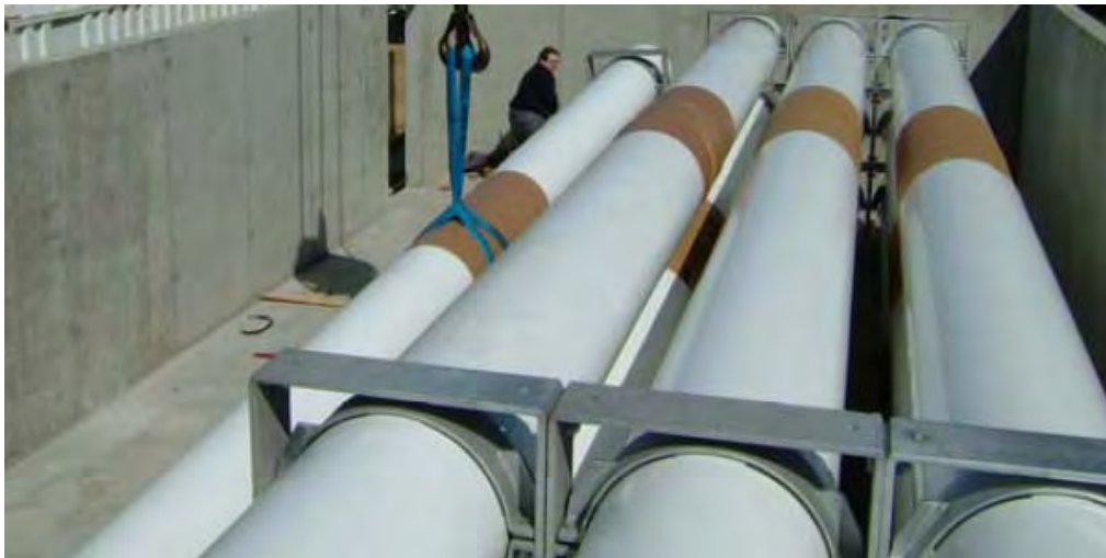
Abbildung 99: Montage der Röhrenspeicher (Quelle: Svensk Växtkraft AB)
