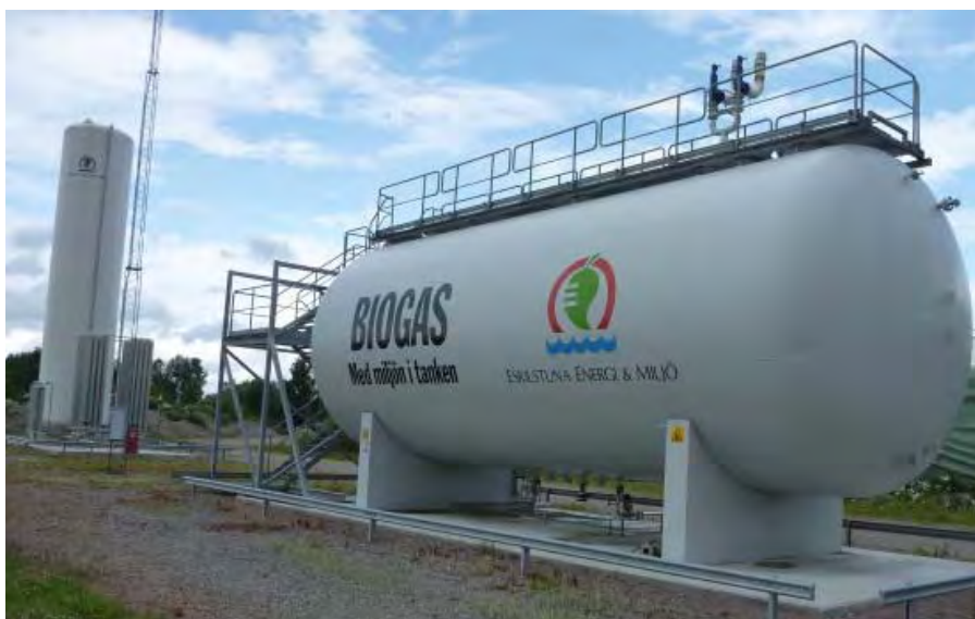
Abbildung 135: LNG-Backup und Biomethanspeicher in Eskilstuna (Quelle: New Energy)
