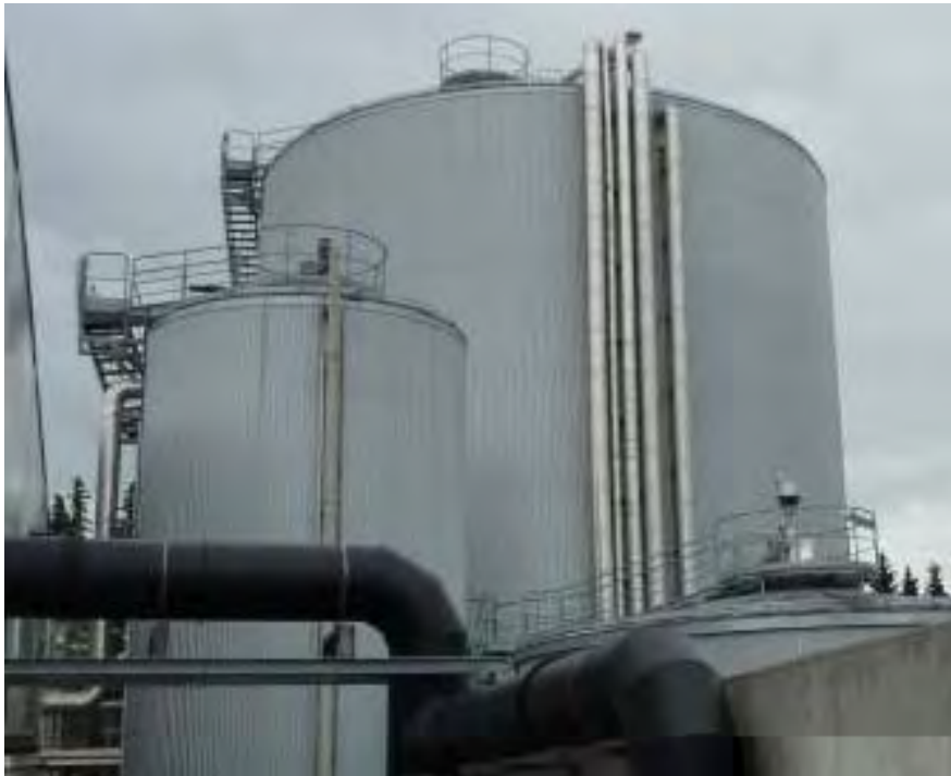
Abbildung 91: Biogasermenter in Västerås (Quelle: New Energy)
