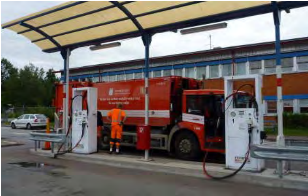
Abbildung 100: Fast Fill Betriebsstation zur Betankung von Bussen und kommunalen Schwerfahrzeugen (Quelle: New Energy)
