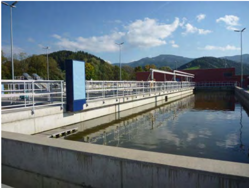
Abbildung 145: Kläranlage in Knittelfeld (Quelle: New Energy)
