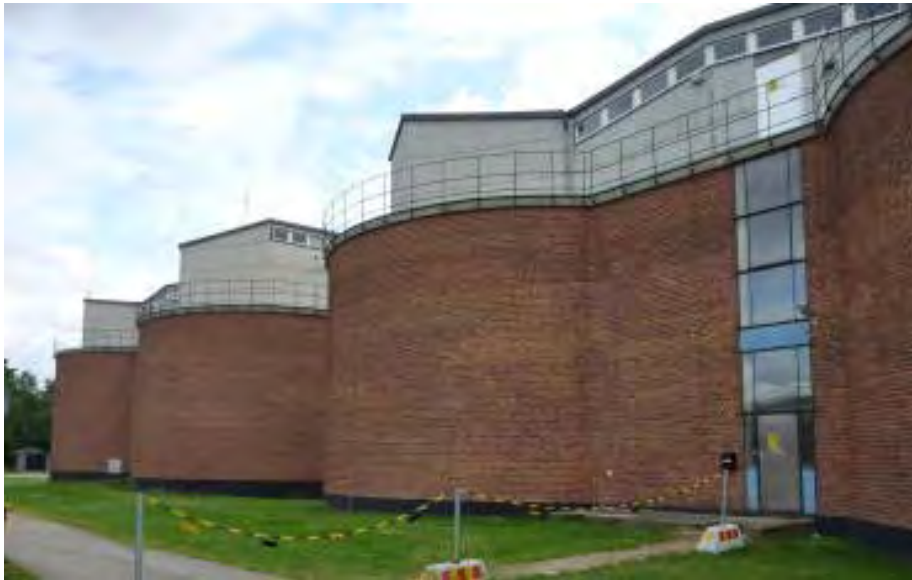
Abbildung 5: Biogasproduktion in Kläranlagenfermentern in Eskilstuna (Quelle: New Energy)
