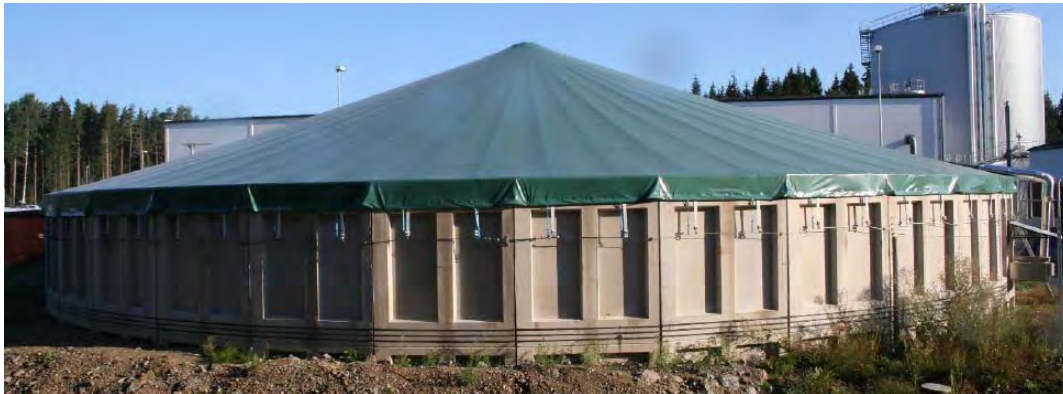
Abbildung 92: Lager für flüssigen Gärrest (Quelle: Svensk Växtkraft AB)
