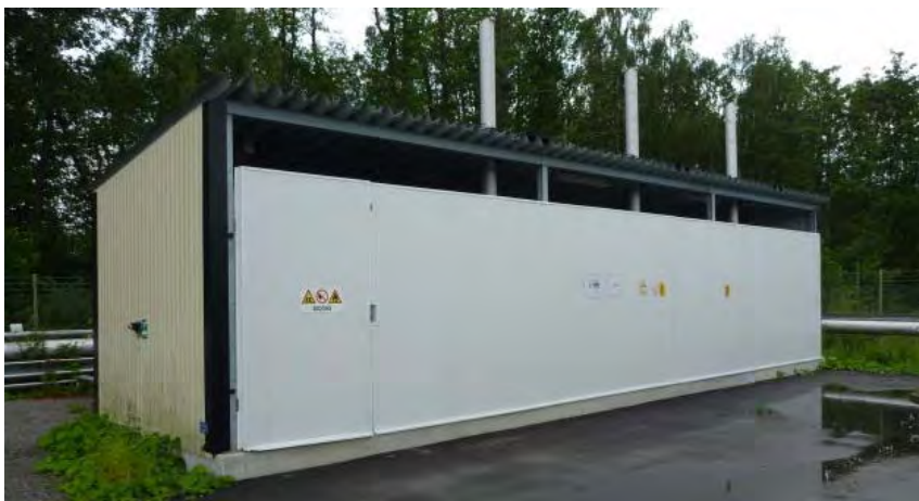
Abbildung 131: Gasspeicher Außenansicht (Quelle: New Energy)
