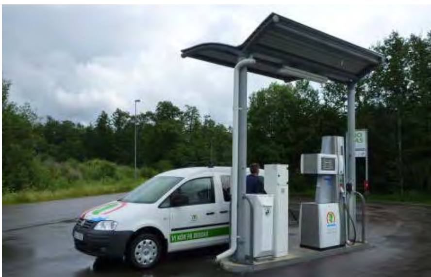
Abbildung 134: Öffentliche Biogastankstelle in Eskilstuna (Quelle: New Energy)
