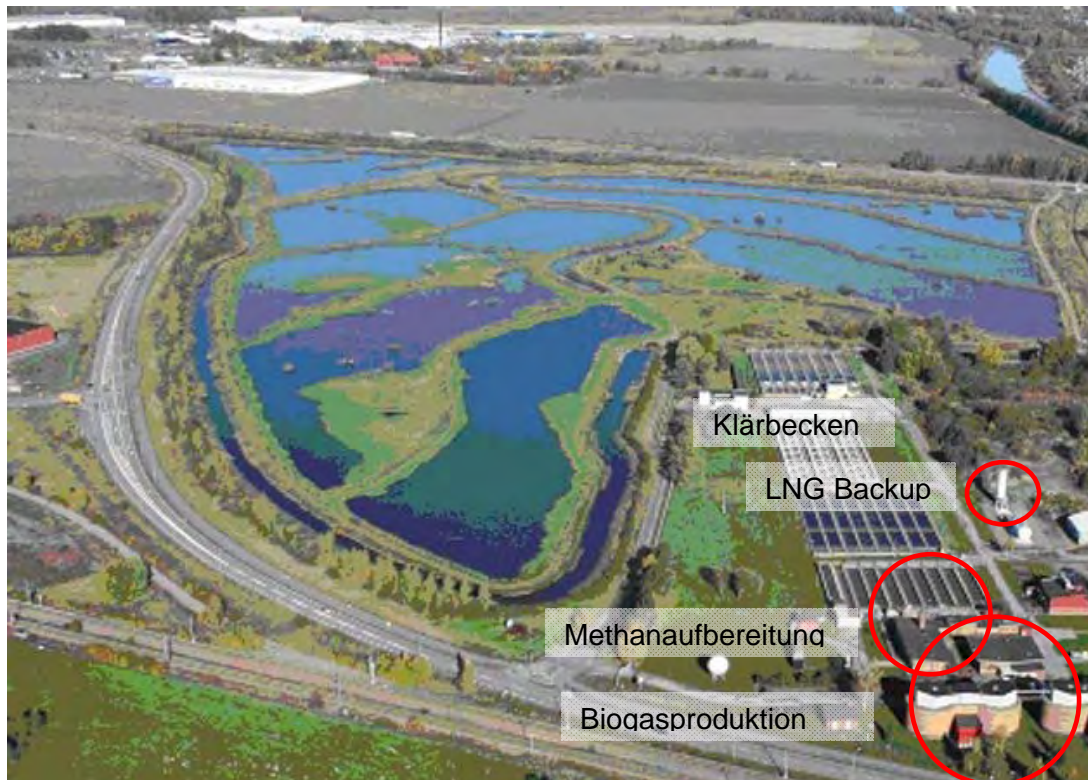
Abbildung 121: Luftbild von Kläranlage, Methanaufbereitung und LNG-Backup in Eskilstuna (Quelle: Eskilstuna Energi och Miljö AB)
