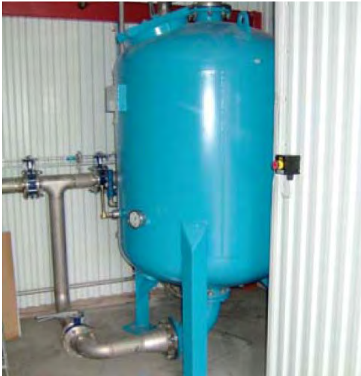
Abbildung 33: Adsorptionstrockner auf der Kläranlage in Kungsängen (Quelle: Svensk Växtkraft AB)
