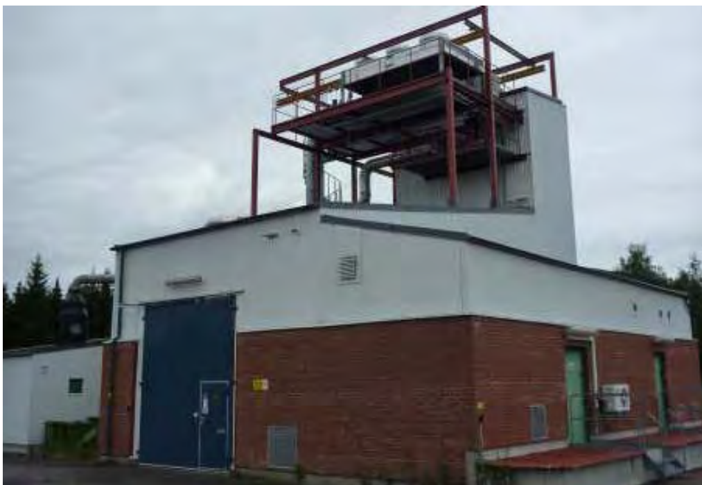
Abbildung 94: Außenansicht Methanaufbereitung Västerås (Quelle: New Energy)
