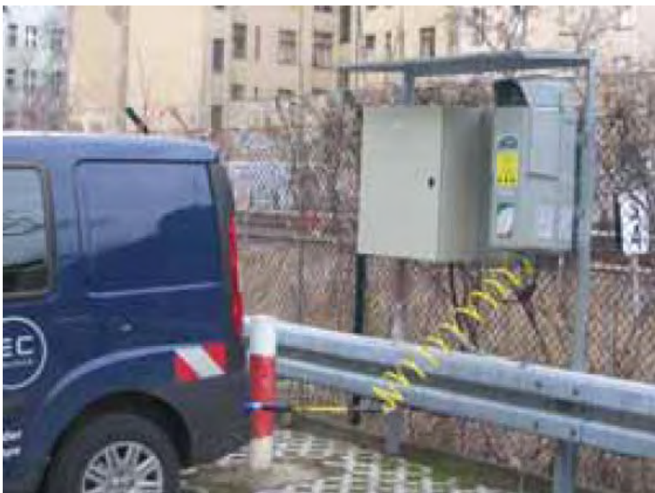
Abbildung 76: Feldtest des Berliner Gasversorgers GASAG (Quelle: GASAG)
