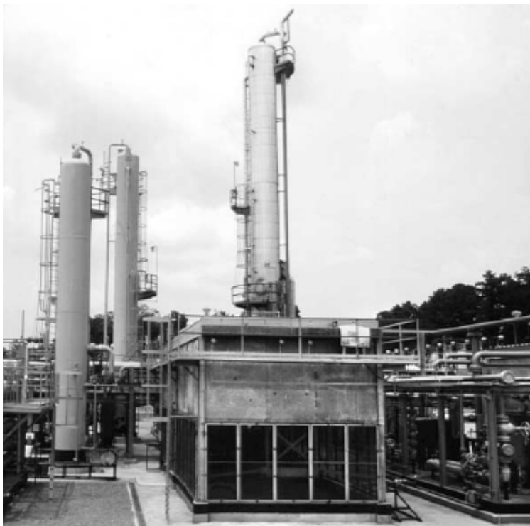
Abbildung 10: Aminowäsche zur Reinigung von Erdgas (Quelle: UOP)
