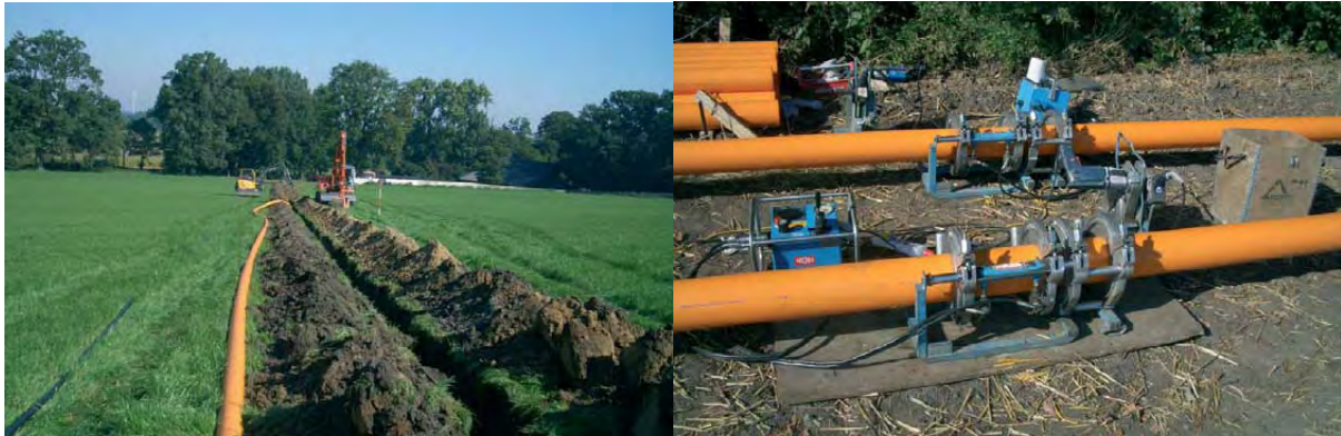
Abbildung 31: Verlegungsarbeiten für Biogaspipeline in Steinfurt (Quelle: EnergieAgentur.NRW)
