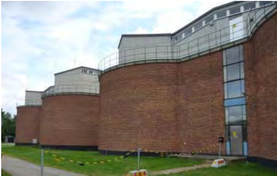
Abbildung 124: Fermenter in Eskilstuna (Quelle: New Energy)
