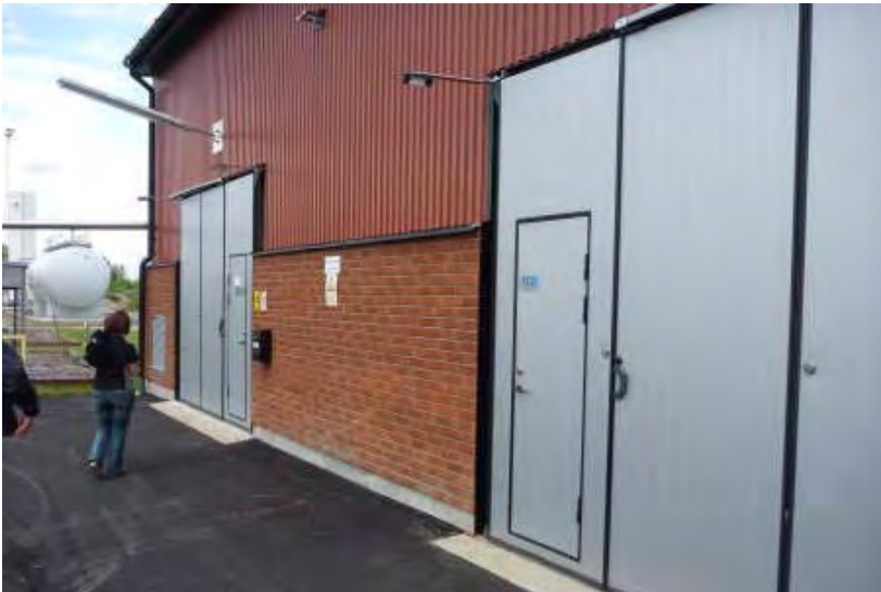
Abbildung 129: Biogasaufbereitung Außenansicht (Quelle: New Energy)
