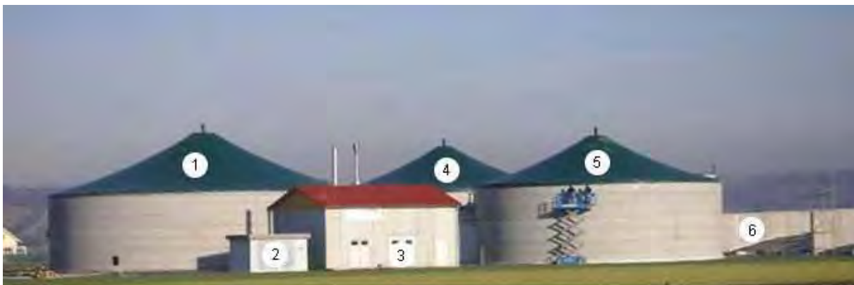
(1) Endlager (2) Trafostation (3) Heizhaus (4) Fermenter 1 (5) Fermenter 2 (6) Fahrsilo
