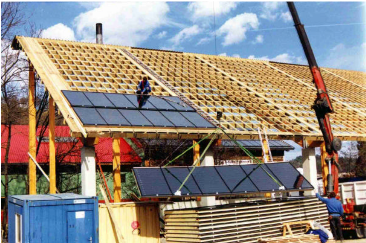
Abbildung 4-1: Montage von Großflächen-Kollektormodulen (Foto: SOLID)
