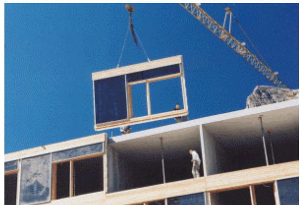
Abb. 12: „Apartmenthaus Adler“ in Hochtannberg Kathan & Strolz Architektur / Innsbruck
