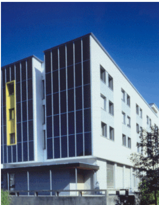
Abb. 15: Fassadenintegrierte Solarzellen Kolpinghaus Dornbirn Architekturbüro - MHM (Dornbirn)
