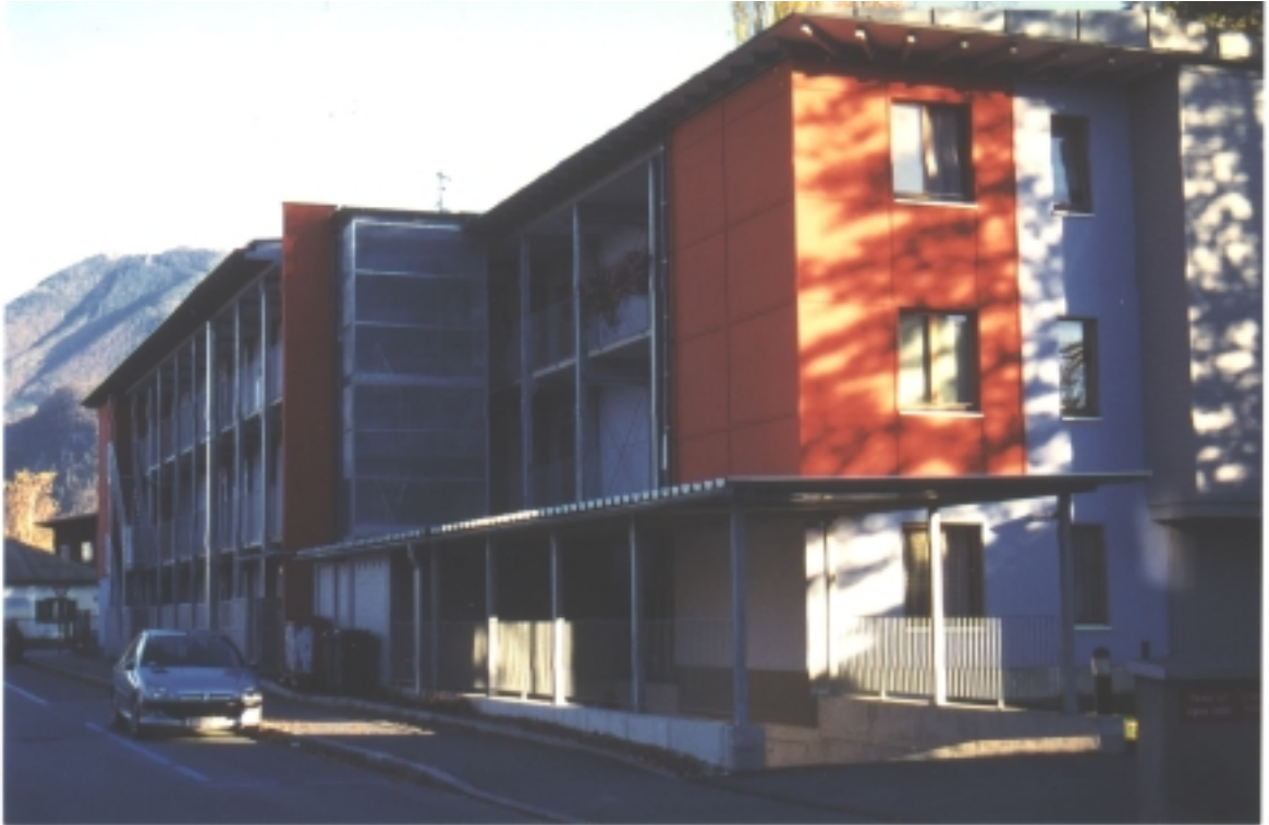
Siedlung Stabauergasse, Salzburg-Schallmoos
