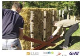
Einzigartig in der Demonstration von Musterwänden ist die Vorführung des Rückbaus der Konstruktion. Der Rückbau funktioniert einfach und ohne Einbezug von Baubefällen.
