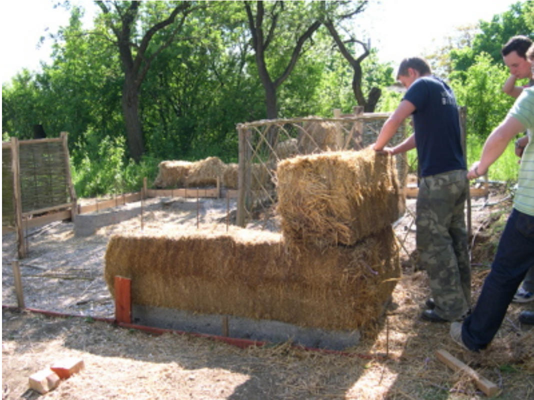
Abbildung 26: Schüler beim Seminar mit praktischen Arbeiten, Errichtung einer lasttragenden Strohballenmusterwand
