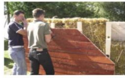
Die Sichtfassade wird mit Holzdübeln befestigt.
