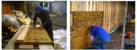
Zerschneiden von Schilfdämmplatten.
