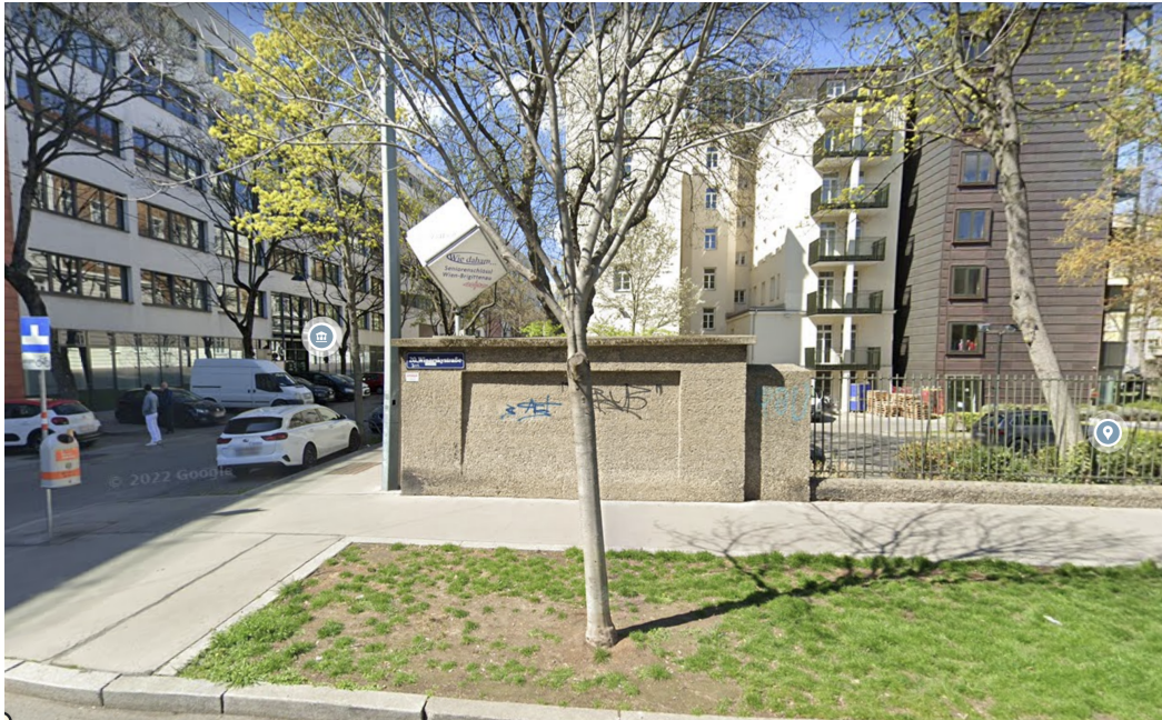
Abbildung 10 Das Obdachlosenheim in der Meldemannstraße mit Zubau links. Auch hier ist das ursprünglich tiefere Straßenniveau des Areals ersichtlich
