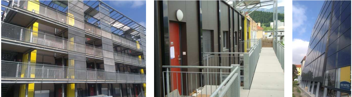
Abbildung 42: Auszüge des fertiggestellten 1. BA des Demonstrationsgebäudes (Quelle: AEE INTEC)
