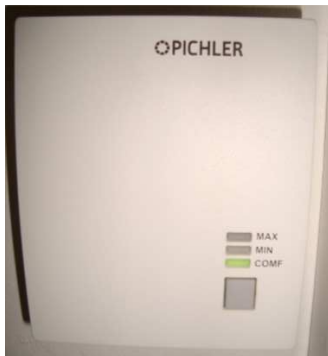
Abbildung 30: 3-stufiger Wohnraumregler (Quelle: AEE INTEC)
