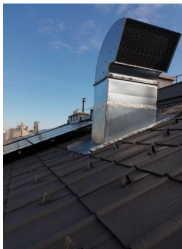
Abbildung 29: Öffnung in der Dachfläche, um den Luftaustausch für die Luftwärmepumpe zu gewährleisten, Außenansicht
