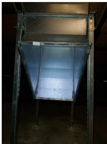
Abbildung 28: Öffnung der Dachfläche für den Luftaustausch der Luftwärmepumpe, Innenansicht
