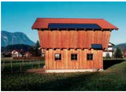
Anlage: DI Bartl, Jenbach
