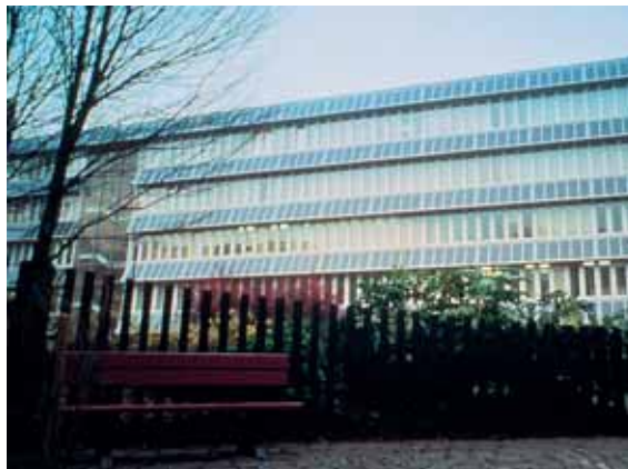
University of Northumbria/Newcastle England. PV integriert in Regen- schutz-Fassadenverkleidung
