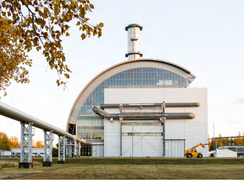
Donaustadt power plant, Photo: Wien Energie/Max Kropitz
