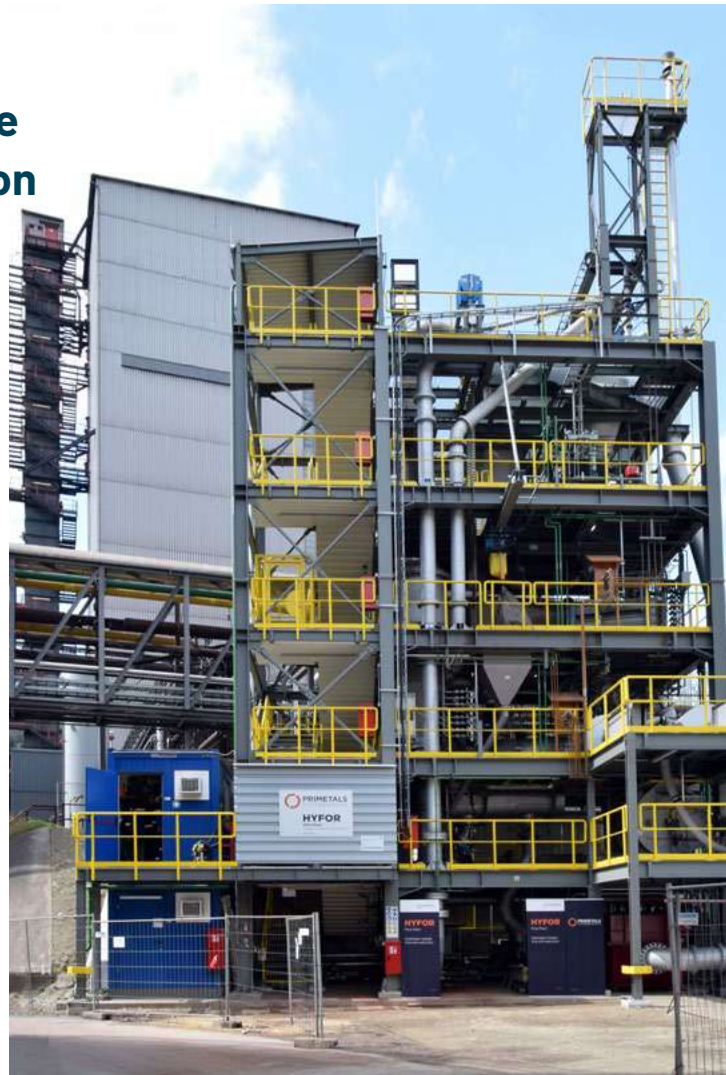
HYFOR ® Pilotanlage, Foto: primetals.com
