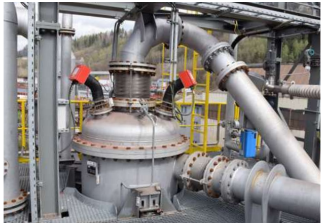
Oberer Erz/DRI Bunker, Foto: primetals.com
