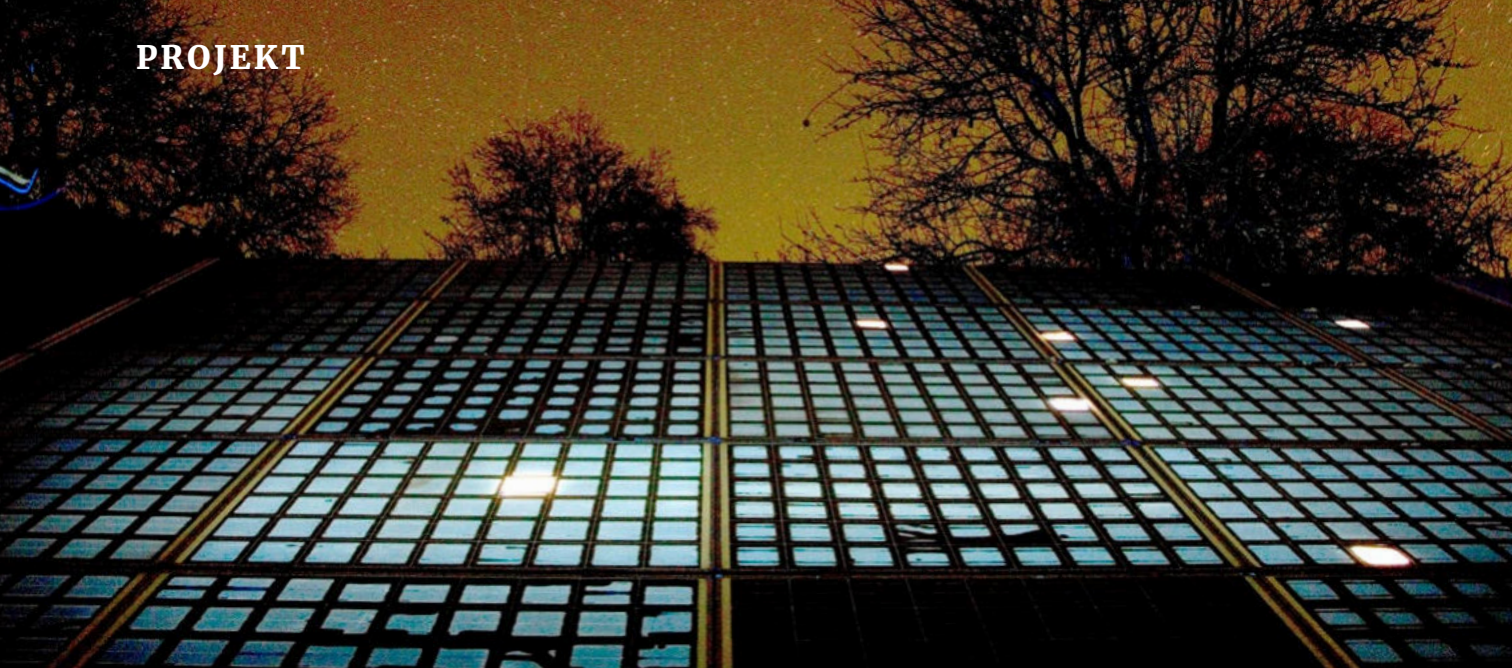
PV-Module bei Beleuchtung mit ultravioletem Licht/ UV-Fluoreszenzmethode (UVF) zur Erkennung von Alterungseffekten, Foto: AIT/B. Kubicek
