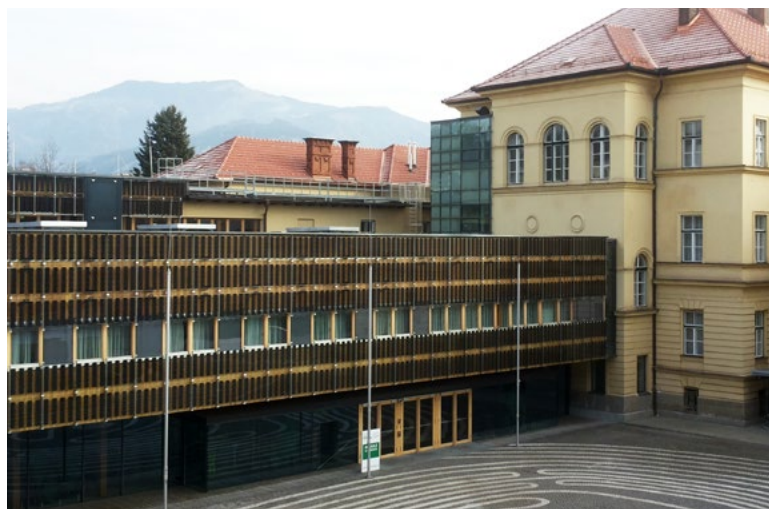
Holz/PV-Glasfassade Höhere Bundeslehranstalt für Forstwirtschaft Bruck a.d. Mur, Foto: AEE INTEC/Armin Knotzer
