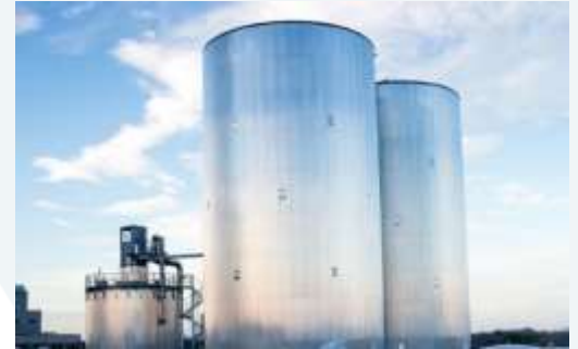
Wien: 2 x 5.500 m 3 Bildquelle: Wien Energie
