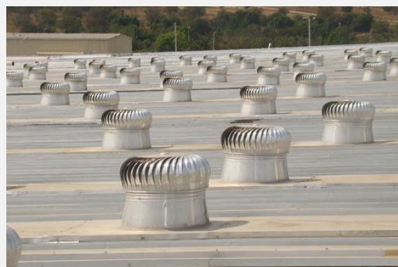
Abbildung 20: Stromlose Dachventilatoren, Airier Natura Pvt. Ltd., Bangalore
