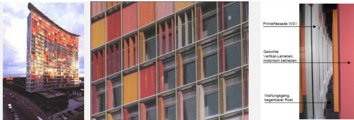
Abbildung 24: Hochhaus Bürogebäude GSW-Zentrale in Berlin. Architect Sauerbruch-Hutton. Westlich ausgerichtete Doppelfassade, Höhe 71 m, Tiefe 1,15 m, innere Hülle Doppelverglasung mit Fensterlüftung, äußere Hülle Einscheibensicherheitsglas. Errichtet 1993 (Quelle: https://www.stylepark.com/de/news/eiskaelte-statt-erdbeben ).
