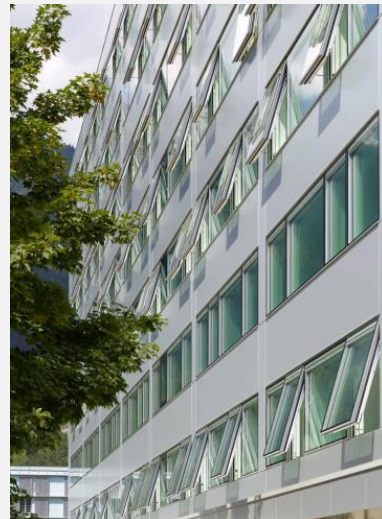
Abbildung 32: Außenansicht und Fassade mit Senklappfenster (Quelle: ATP Architekten Ingenieure)
