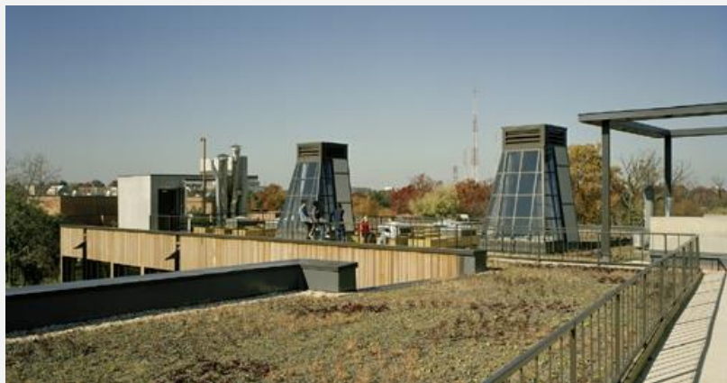
Abbildung 16 Solar-Lüftungskamine, Sidwell Friends School, Washington D.C., USA. Erweiterung und umfangreiche Sanierung, abgeschlossen 2008. Planung: Kieran Timberlake Associates. (Quelle: www.solaripedia.com , 29.12.2014).
