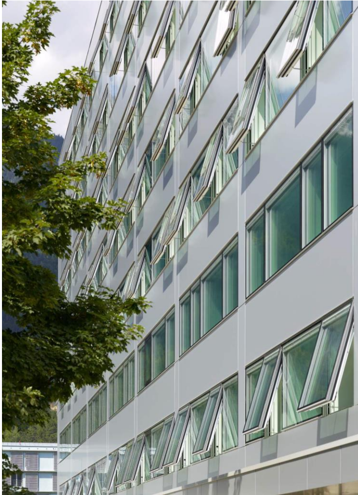
Abbildung 5-17 Fassade, Quelle: ATP Architekten Ingenieure
