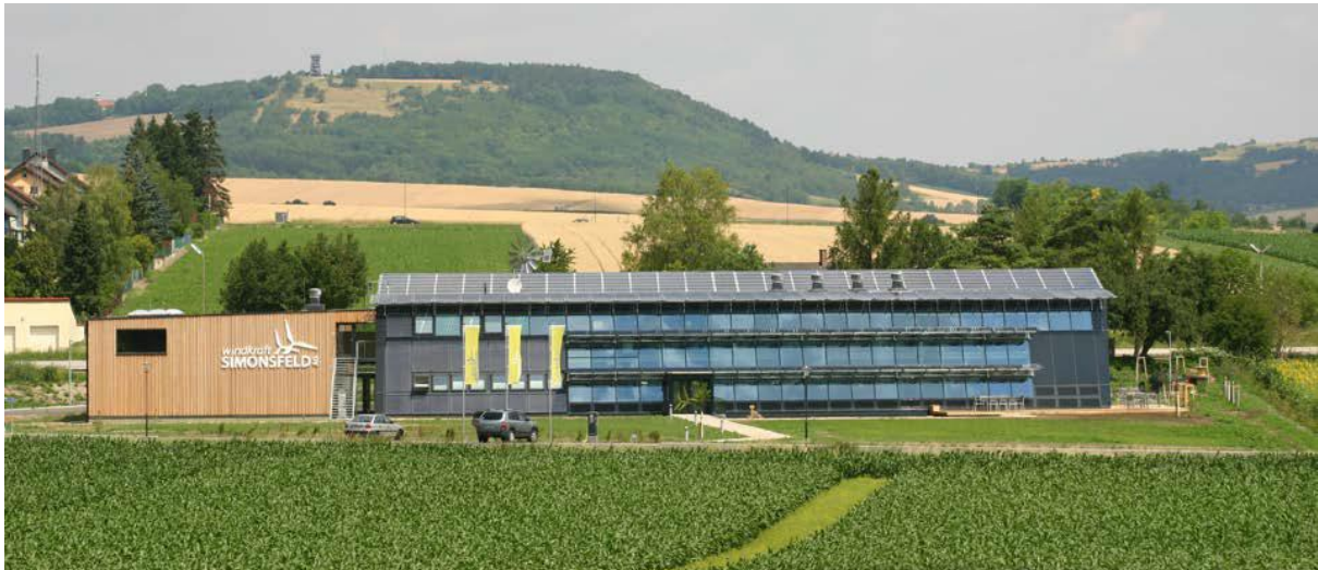
Abbildung 5-27: Ansicht Windkraft Simonsfeld, Quelle: Architekturbüro Reinberg ZT GmbH
