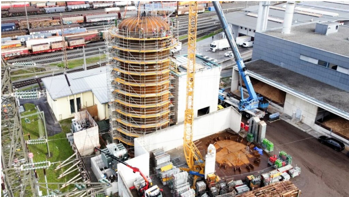
Abbildung 112 – Errichtung des Großwärmespeichers in Hall in Tirol mit 1.400 m 3 und 97 MWh thermische Kapazität mit Fertigstellung im Dezember 2022 Bildnachweis: © www.kremsmueller.com
