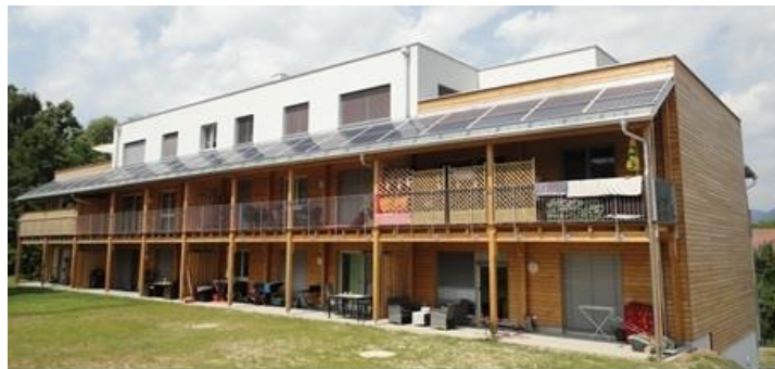
Abbildung 5-23: Bild des untersuchten Mehrfamiliengebäudes in Weiz (Hutter 2016)
