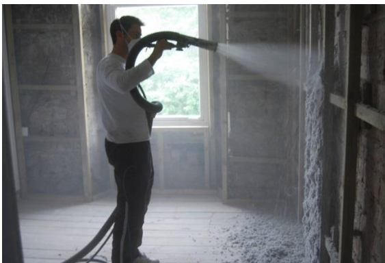
Abbildung 8: Aufbringen der nassen Cellulose im Sprühverfahren © HES
