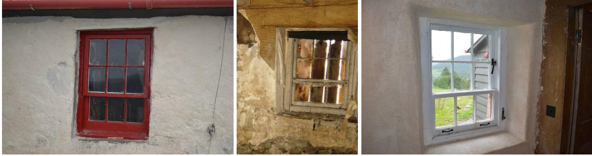
Abbildung 4: Beispiel für das Reparieren eines Fensters - Best Practice Beispiel Downie's Cottage, © HES
