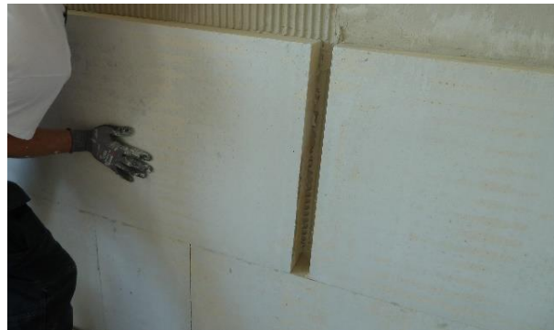
Abbildung 7: Installation von PUR-Schaum Platten mit integrierten kapillaraktiven Kalziumsilikat-Röhrchen, © AAU
