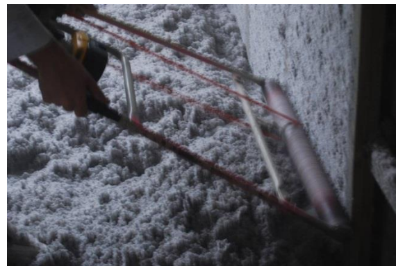
Abbildung 9: Glätten des Zellulosematerials vor dem Anbringen der Gipskartonplatte © HES
