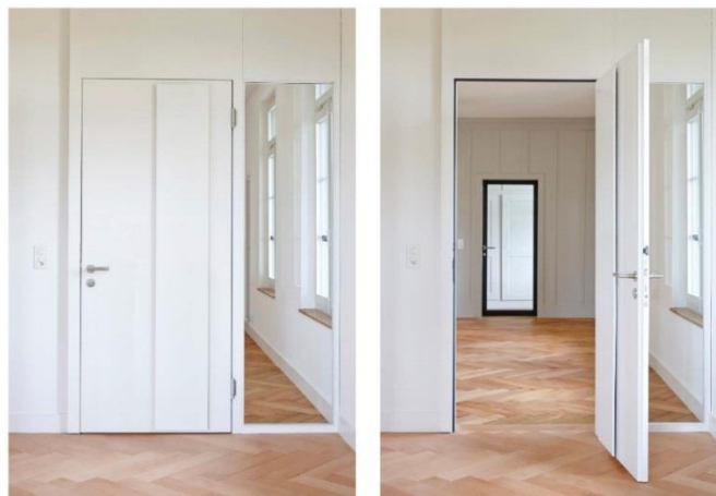
Abbildung 10: Active overflow System als sogenannter „Verbundlüfter“ der Firma Erich Keller. Im denkmalgeschützten Herrenhaus Brünnengut in Bern (Schweiz) wurde der aktive Überströmer in das Türblatt integriert.
