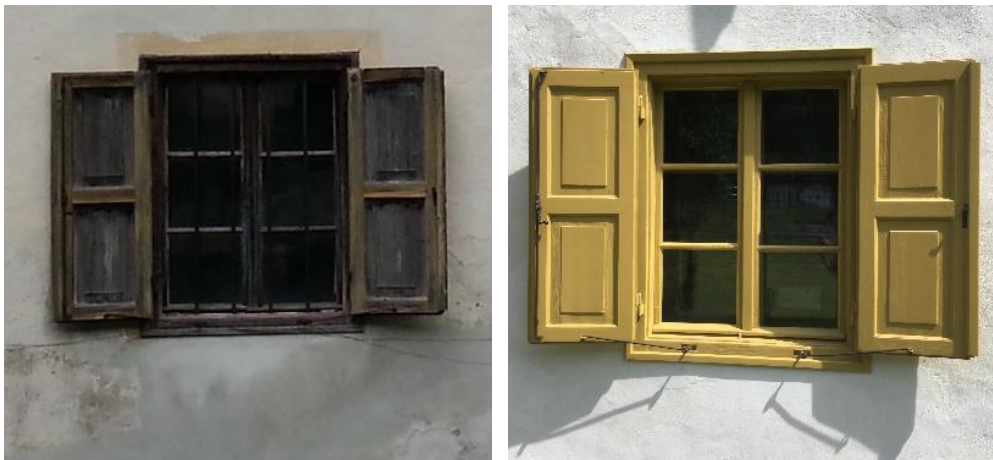
Abbildung 5: Beispiel für den Austausch des Glases am inneren Flügel (Links: vor der Sanierung; Rechts: nach der Sanierung) - Best Practice Beispiel Knablhof, © Darius Richter
