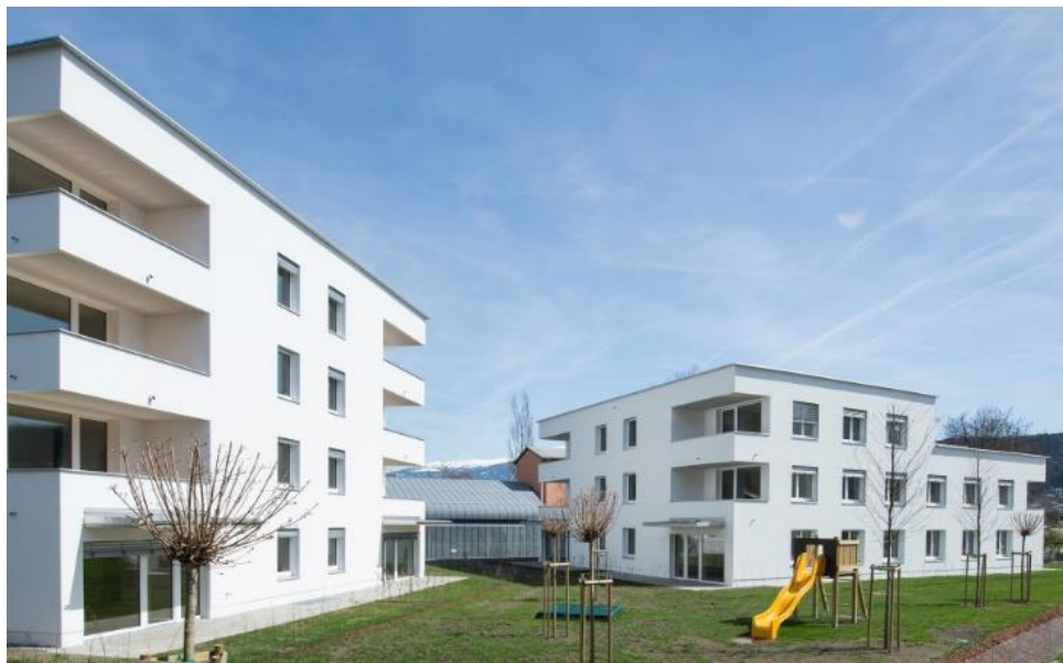
Abbildung 6-1 – Ansichten der Gebäude (linker Nordblock, rechter Südblock). Mit freundlicher Genehmigung von Neu Heimat Tirol (NHT).
