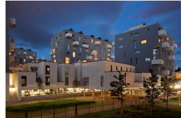
Abb. 13 Stadtwerk Lehen, Foto: Fotohof Phelps
