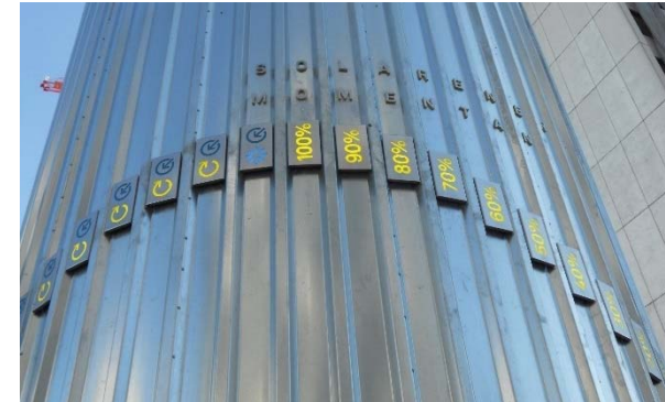
Abb. 54 Visualisierung auf dem Pufferspeicher als flexible Darstellung der solaren Gewinne , Foto: SIR, Strassl
