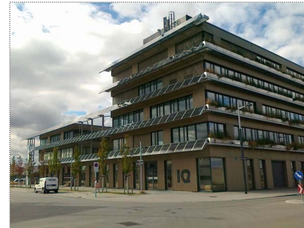
Abb. 23 Aspern IQ - erstes Gebäude in aspern Seestadt Foto: Daiva Jakutyte-Walangitang
