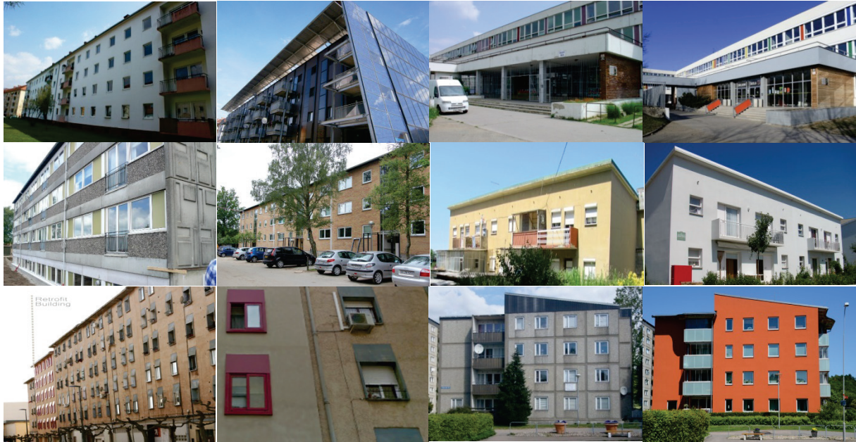
Abbildung 15: Als "Case Studies" untersuchte Gebäude vor und nach deren Sanierung, links oben: Österreich, links Mitte: Dänemark, links unten: Spanien, rechts oben: Tschechische Republik, rechts Mitte: Portugal und rechts unten: Schweden (Quelle: IEA EBC Annex 56)
