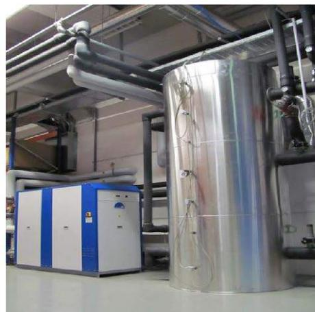
Abbildung 94: Kompressionswärmepumpe @ Seidel, Deutschlandsberg (Klima:aktiv, 2011)
