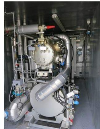
Abbildung 84: NH<sub>3</sub> Kompressionswärmepumpe (Foto: AIT, Andreas Zottl)
