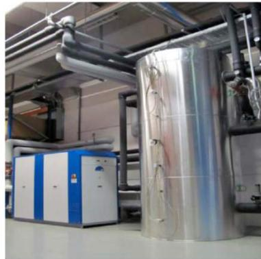
**Figure 7: Compression heat pump at Seidel, Deutschlandsberg (klima:aktiv, 2011)**
