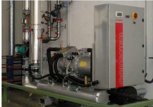
Abbildung 86: Ochsner Wärmepumpe – Gebauer & Griller (Foto: Ochsner, 2009)
