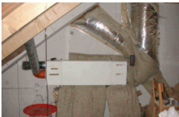
Beispiel eines Lüftungsgerätes im Spitzboden eines Altbaues mit teilweise gedämmten Rohren (rechts)
