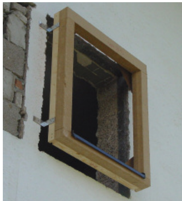
Fenstermontage vor der Altbaufassade mittels Metallwinkeln
