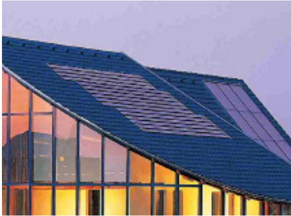
Hausdach mit Photovoltaik und Thermischer Solaranlage
