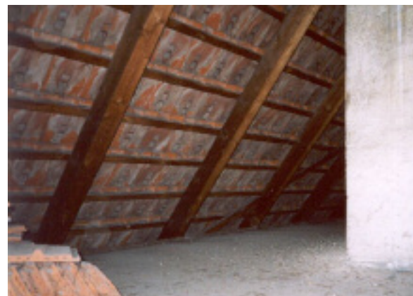
Oberste ungedämmte Geschoßdecke und Dach
