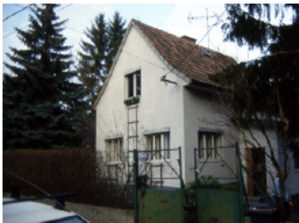
Wohnhaus vor der Sanierung
