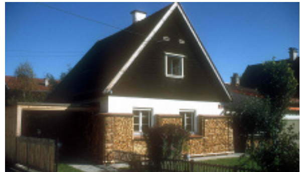
Wohnhaus vor der Sanierung
