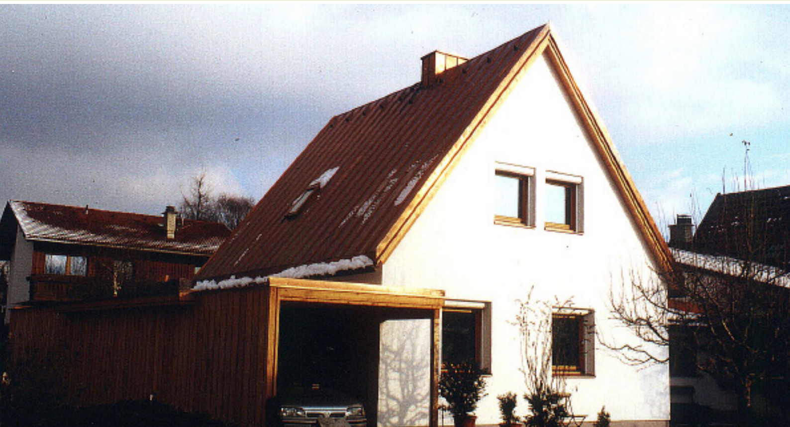
Projekt Wehinger: Siedlungshaus nach der Sanierung
