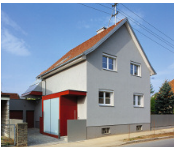
Strassenseitige Ansicht nach der Sanierung
