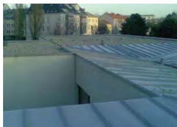
Flachdach - Lernwerkstatt Donaustadt Steinbrechergasse Wien
