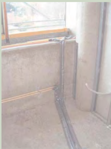
Abbildung 5 + 6: Bauteilheizung in der Gärtner und Floristenschule mit Grundlastkreis im Betonparapet und Heizkreis unter dem Fensterbrett und in den Fensterstehern als reine Strahlungsheizung; Schematische Wandabwicklung Bauteilheizung (rechts)
