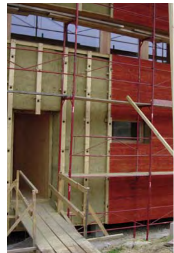
S – House in Böheimkirchen aus strohgedämmter Holzkonstruktion in Passivhausbauweise
