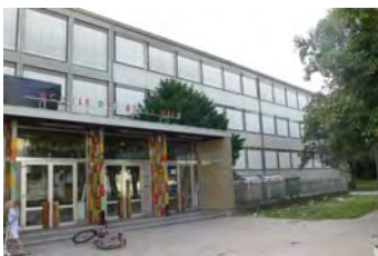
Stiegenhausverglasung und Eingangsfassade späte Nachkriegsmoderne – Kooperative Mittelschule Roda-Roda-Gasse Wien
