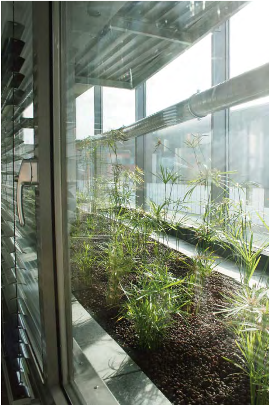
Passiv-Büro- und Gewerbehäuser ENERGYbase in Wien Floridsdorf, Pflanzen-Pufferräume zur natürlichen Konditionierung der Luft
