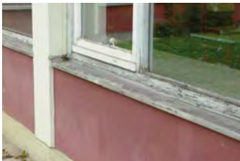
Bestandsfassade frühe Nachkriegsmoderne – VS/HS Schirmitzbühel Kapfenberg
