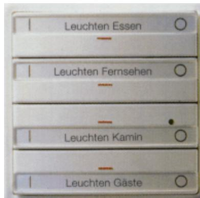
Bild 5: Display eines 4-Kanal Reglers für die Lichtstärke mit EIB-Bus
