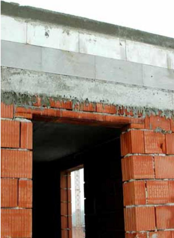
Abb. 3.5: Attikaausführung mit Gasbetonsteinen
