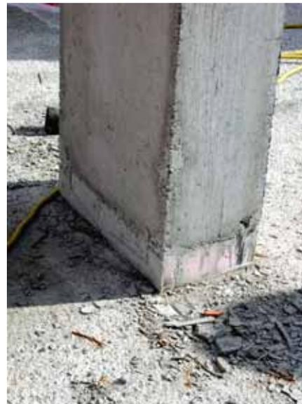
Abb. 3.3: Fußpunkt Stahlbetonpfeiler mit Isokorb und Wärmedämmung
