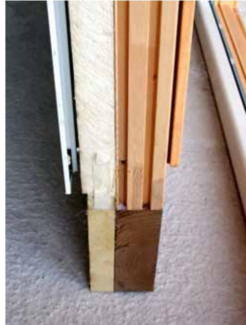
Abb. 3.9: Schwelle der Fixverglasungselemente mit Purenit-Streifen
