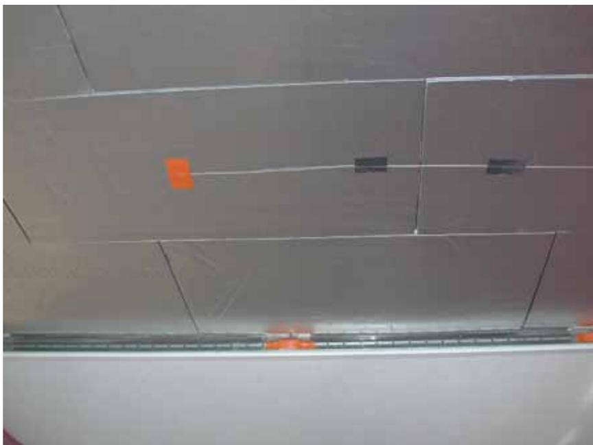
Abb. 3.22: Vakuumdämmplatten an der Deckenuntersicht verlegt
