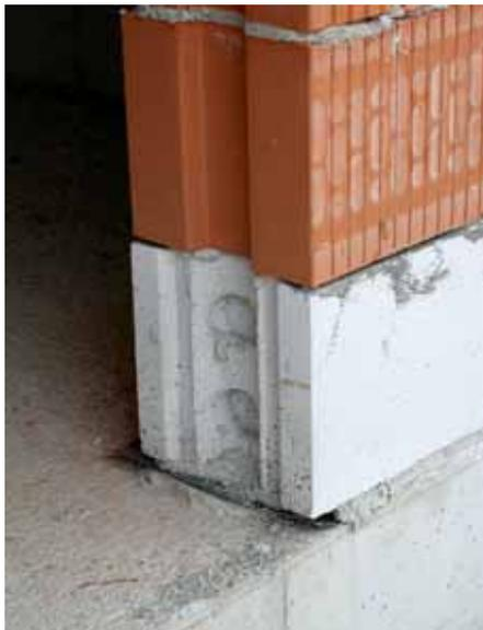
Abb. 3.2: Gasbetonsockel beim Ziegelmauerwerk
