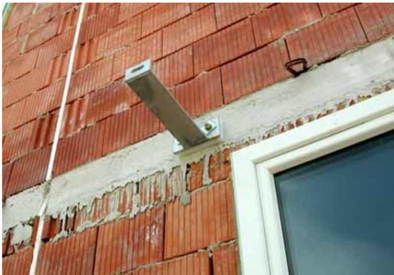
Abb. 3.6: Thermische Trennung der Vordachverankerung
