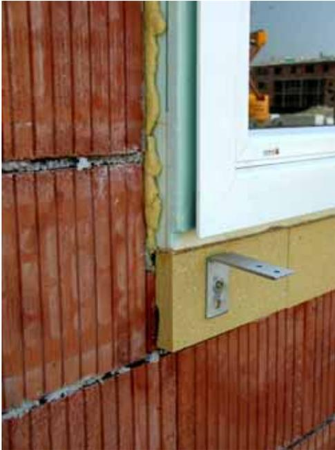
Abb. 3.8: Einbau der Passivhausfenster
