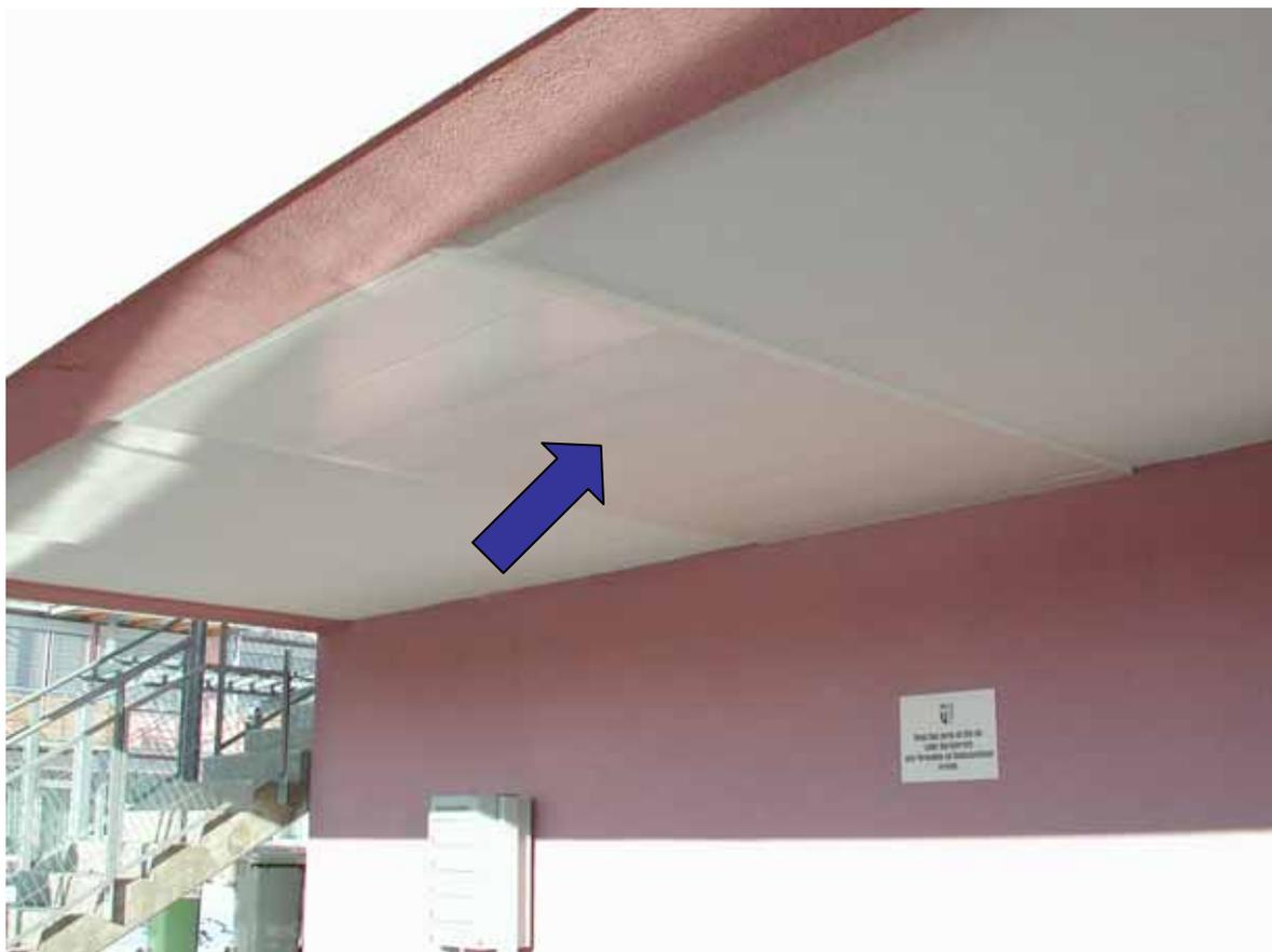
Abb. 3.19: Durchgang Haus 1 mit Vakuumdämmung oberhalb der weißen Metallkassettendecke (blauer Pfeil)
