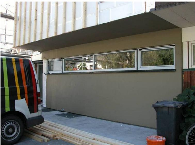
Fertig beschichtetes unverputztes Capatect Schienensystem mit VIP
