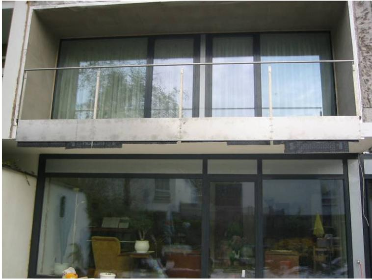
Im Bereich des Balkons Süd wurde ebenfalls aus Platzgründen VIP mit EPS verklebt und verputzt. Deutlich erkennbar, die dünnen Dämmschichten am Rand der Loggia umlaufend.
