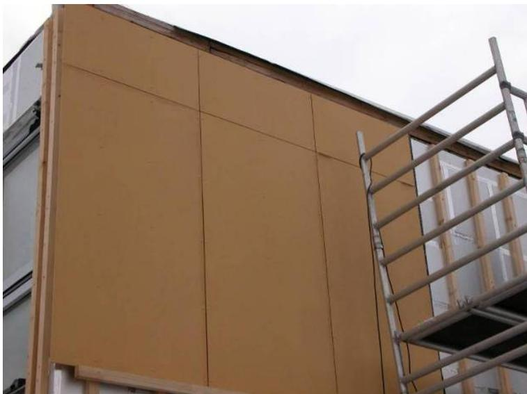
Bild 38: Nordfassade mit Cem-Board Platten
