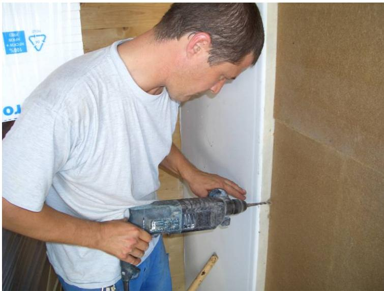
Bild 17: Bohrungen werden nach Dübelbild erstellt
