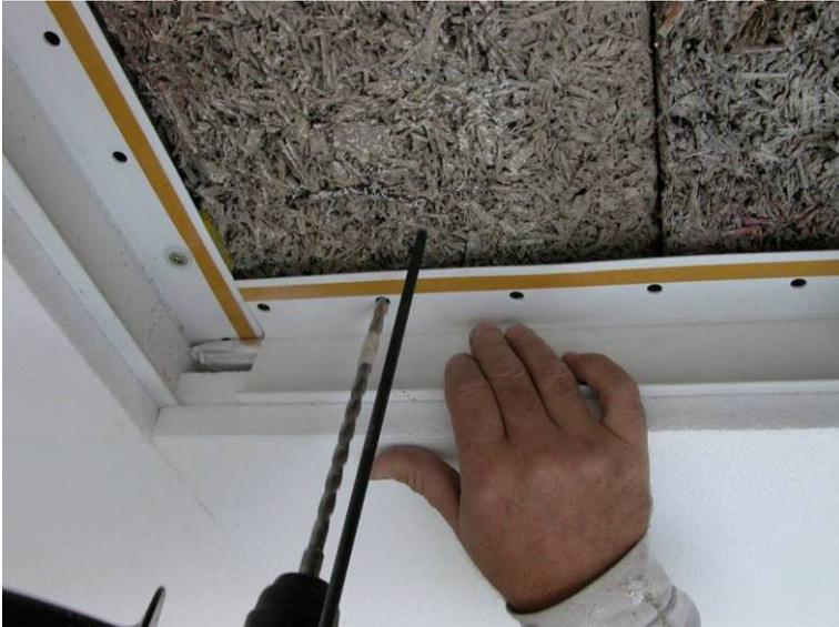
Bild 39: Die Schiene wird befestigt
