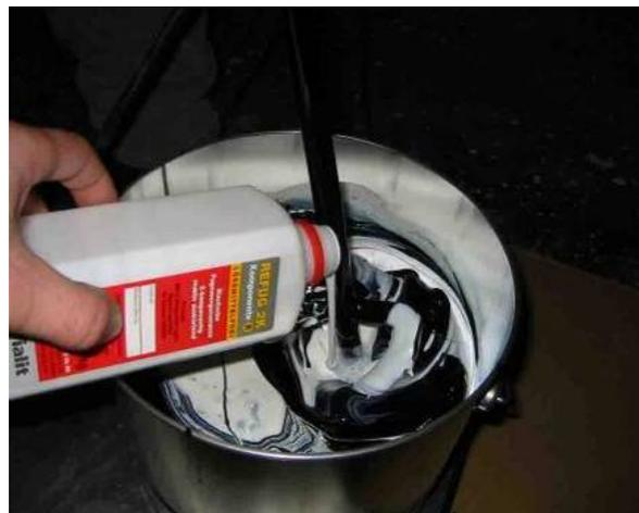
Bild 16: Das 2-Komponenten Reaktivbitumen
