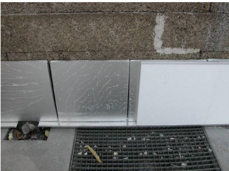
Bild 41: Die VIP in der Sockelschiene
