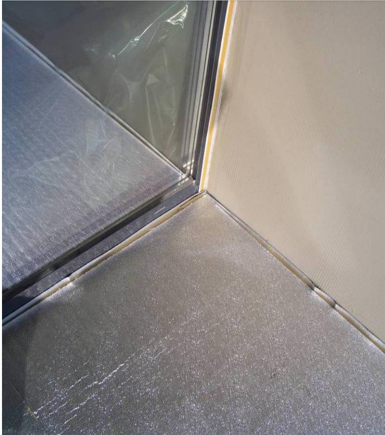
Die oberste Lage Wärmedämmung, bevor die Abdichtungsbahn aufgebracht wird.
