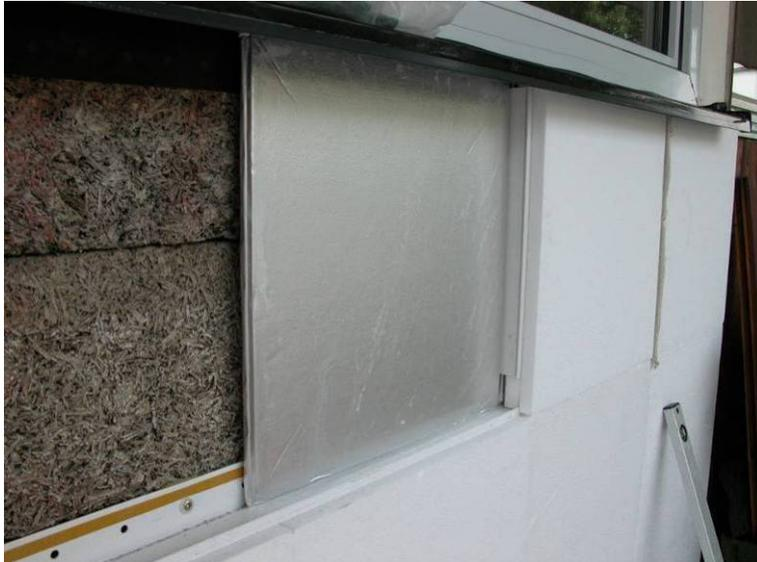
Schnitt durch das Schienenbefestigungssystem
