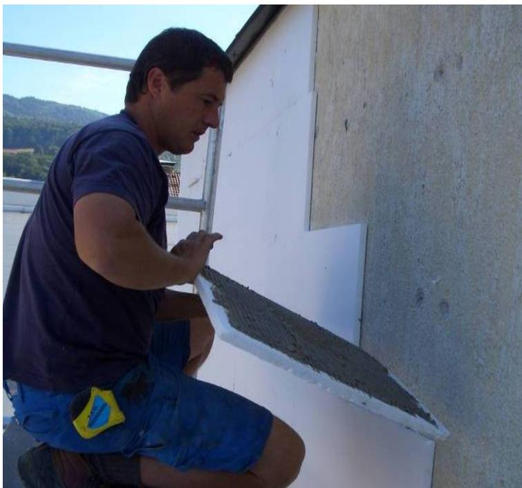
Bild 30: Die EPS Platten werden aufgeklebt
