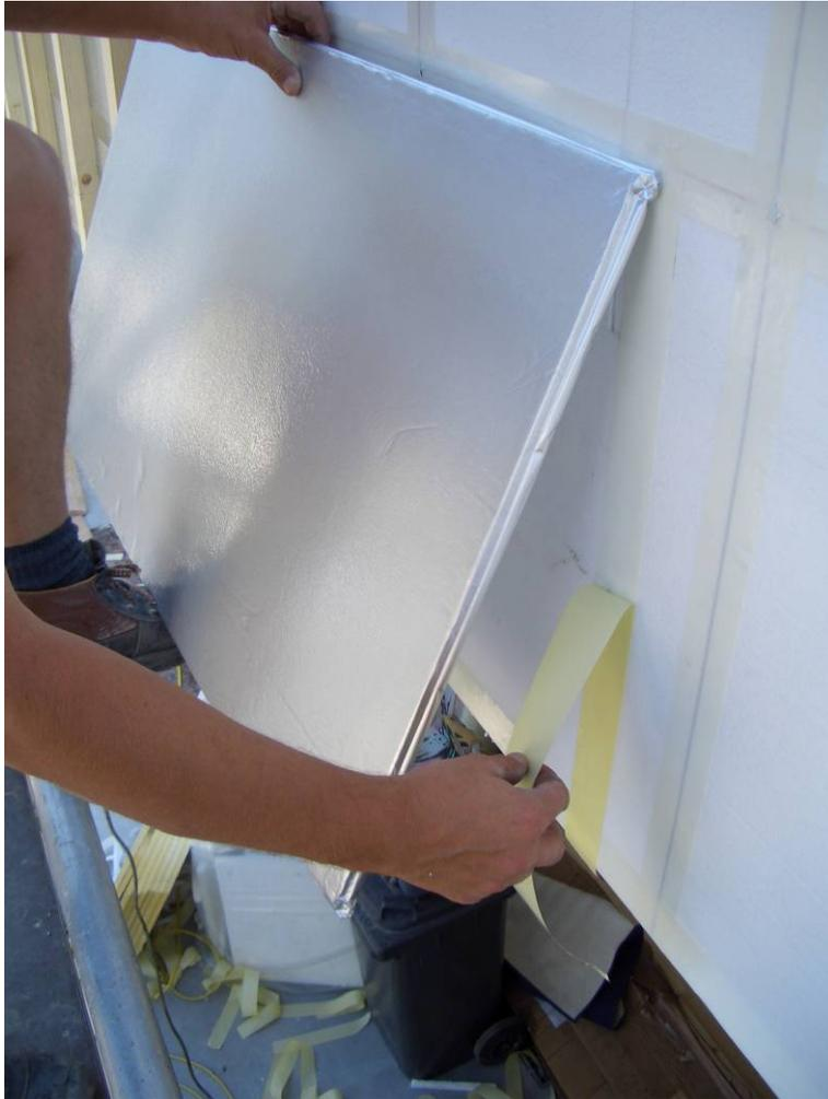
Die Dämmplatten werden im Stoßbereich durch ein Doppelklebeband luftdicht an den Untergrund angeschlossen, und bis zur endgültigen Montage der Montagelatte gehalten.
