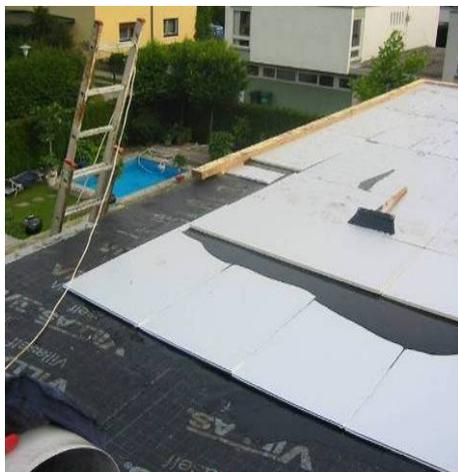
Bild 15: Aufbau der Dachdämmung
