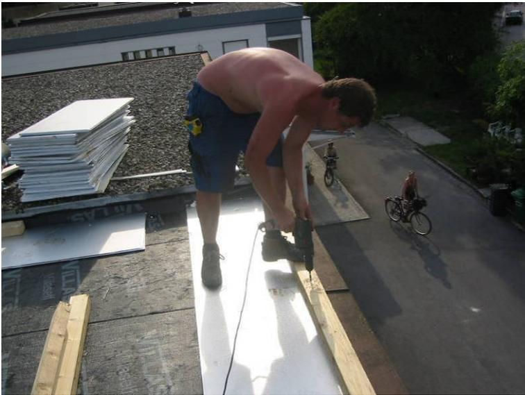
Bild 23: Die Attika Holzbohle wird aufgebracht
