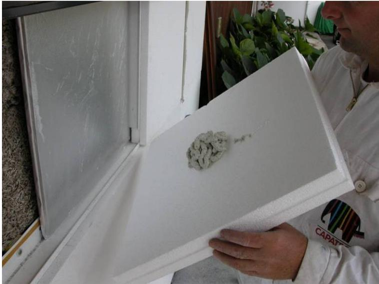
Bild 42: Die EPS Platte wird aufgebracht
