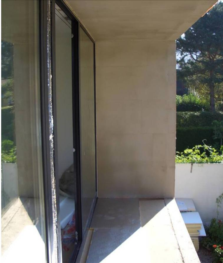
Die Balkonkragplatte wurde im Bereich von ca. 80cm mit VIP, danach mit Alu kaschierten PUR Platten gedämmt. Diese Maßnahme wurde umlaufend ausgeführt.
