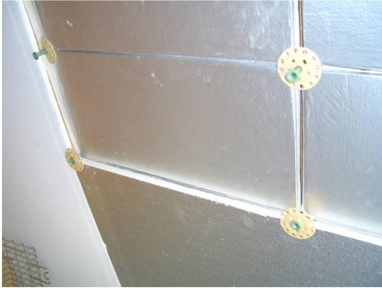
Bild 19: 2. Lage PUR Platte mit variablem Dübelteller (oben)
