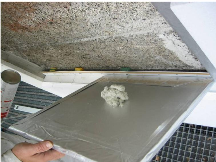
Bild 40: Die VIP wird mit PU Kleber fixiert
