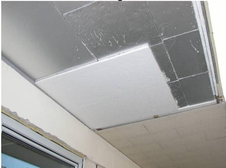
Die Dämmplatten wurden mit Rollkleber am Bauteil fixiert.
