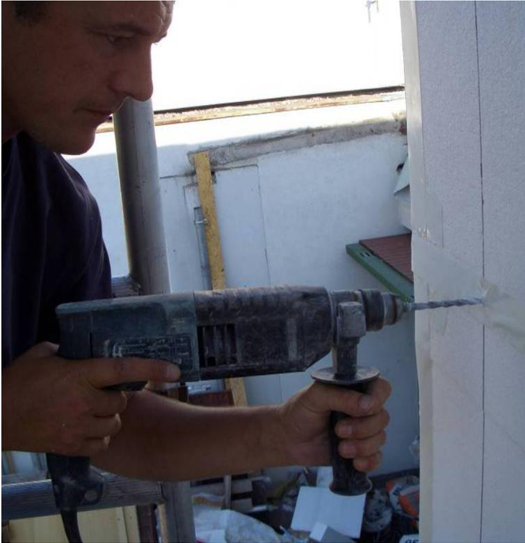
Auf der Styroporschicht wird der Raster für die Dübelung erstellt. Anschließend werden die erforderlichen Bohrlöcher, unter Berücksichtigung des VIP-Rasters und der Cem-Board Platten ausgeführt.
