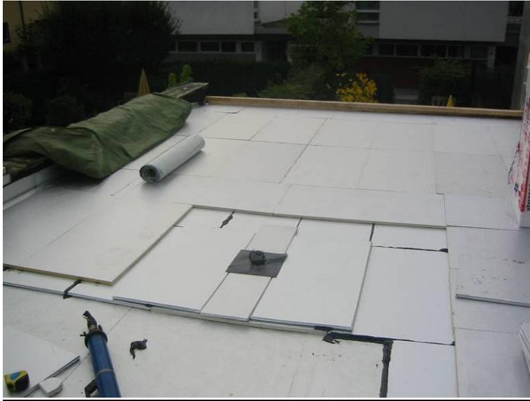
Bild 28: Die Terrasse mit der verlegten Wärmedämmung
