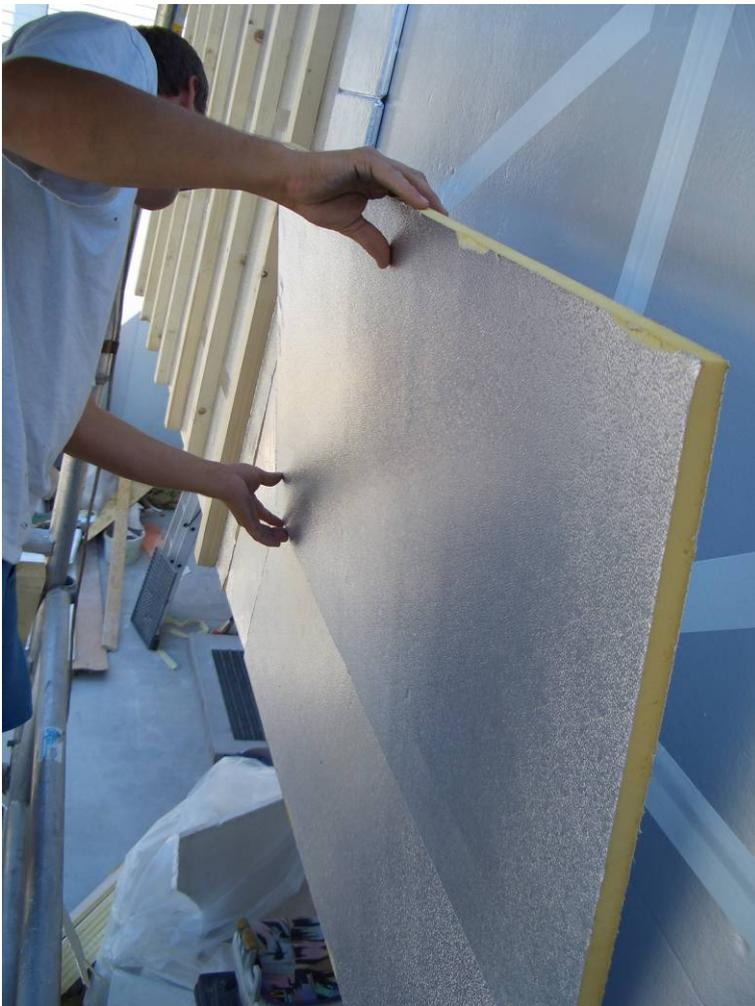
Bild 36: Die PUR Platte wird aufgebracht
