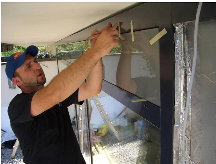
Bild 55: Die emaillierte Verglasung wird eingesetzt
