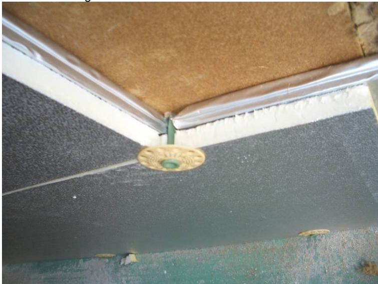
Bild 18: Schnittmodell „mechanische Befestigung“
