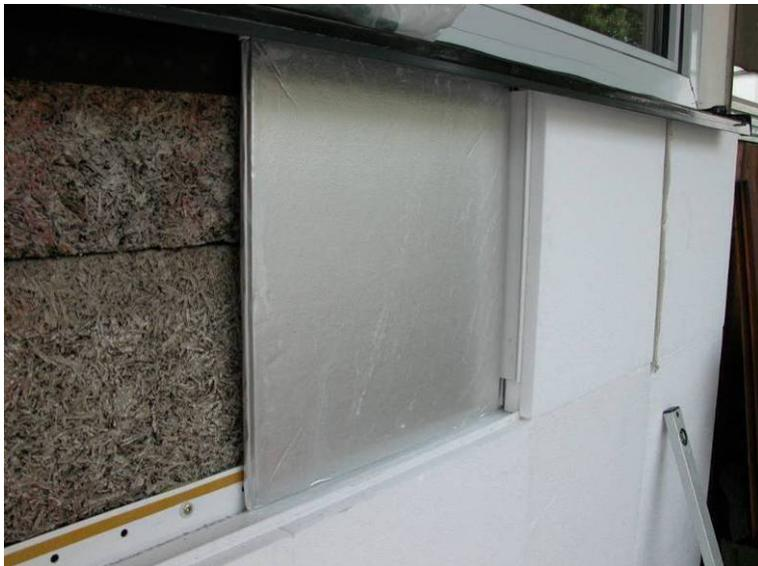
Bild 43: Schnitt Aufbau durch Capatect Schienensystem mit hinterlegter VIP
