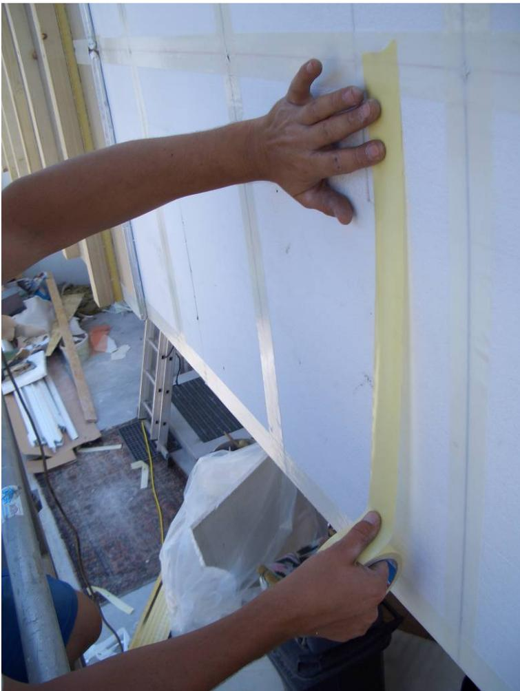
Mit doppelseitigem Klebeband wird sodann die Lage VIP auf die EPS-Lage aufgeklebt und die dabei entstehenden Fugen abgeklebt. Durch fertigungsbedingte Maßtoleranzen der VIP liegen die Fugengrößen zwischen 4-10 mm. Danach werden die Spezialdübel in das gebohrte Loch versenkt. Die Fugen zwischen den VIP und Dübeln werden dann an der Außenseite wieder mit doppelseitigem Klebeband abgeklebt.
