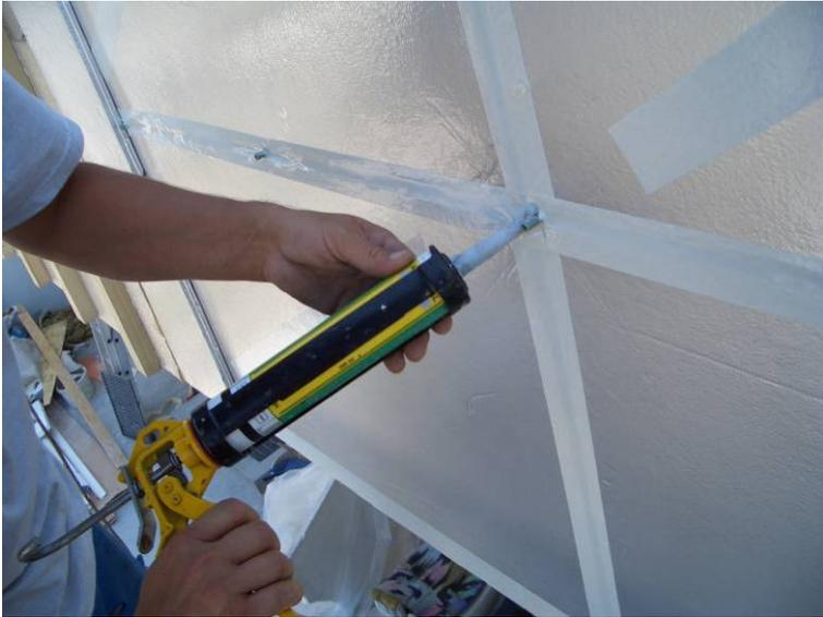
Bild 35: Die Luftdichtheitsmasse
